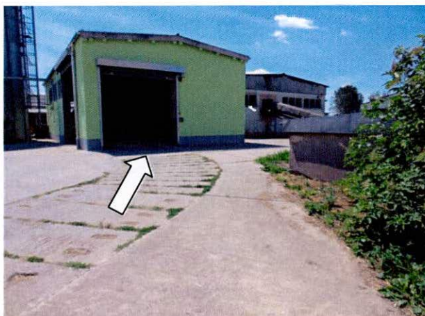
Abbildung 16: Zufahrt zum Anbau Futtermittelhaus
