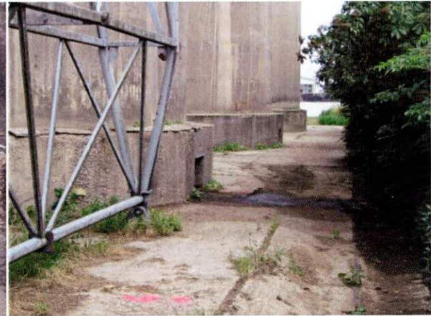
Abbildung 23: Betonfläche vor Tunnelabzug Silo 3
