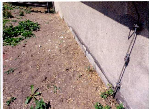
Abbildung 17: Anfüllung BMSR-Zentrale
