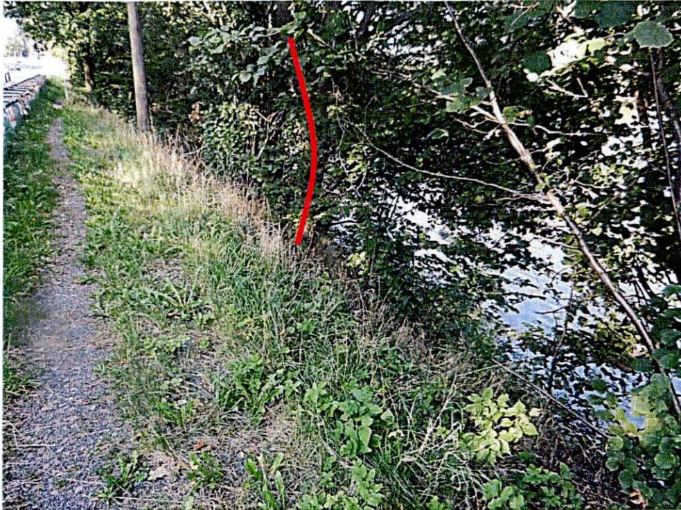
Abbildung 4: Damm am Rossendorfer Teich, wasserseitige Böschung, mit Hervorhebung Säbelwuchs
