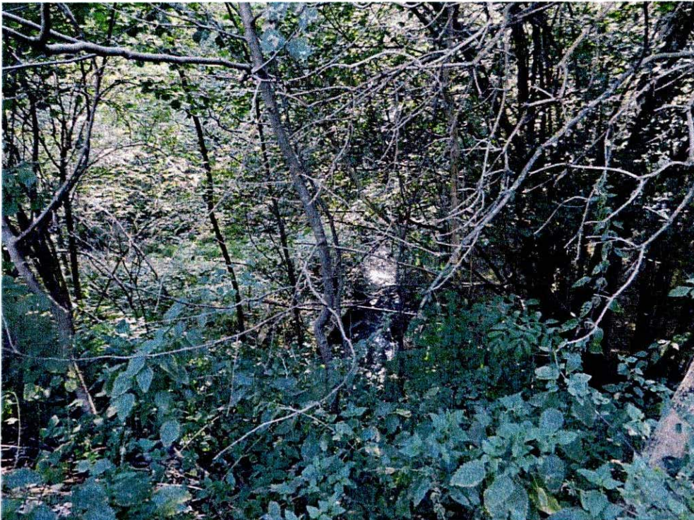
Abbildung 5: Damm am Rossendorfer Teich, luftseitige Böschung mit Auslass der Prießnitz
