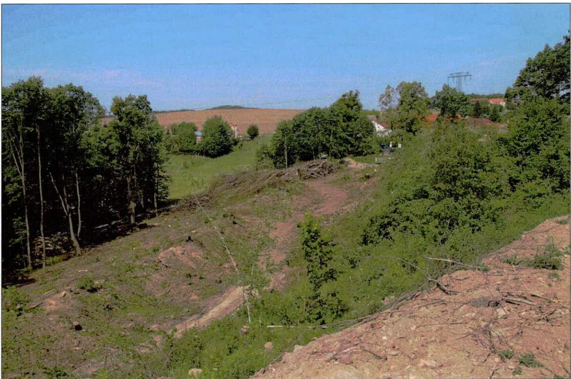
Abb. 14. Abgeholzter Haldenhang südlich des Gewerbe- und Wohnparks Eschdorf/Rossendorf an der S 177 (31.05.2018).
