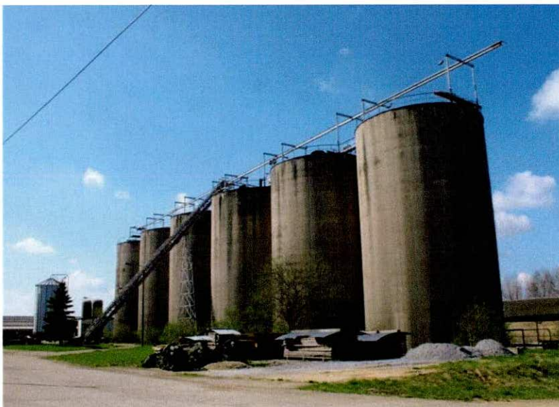
Foto 34: Hochsilos des LU „An der Dresdner Heide“
