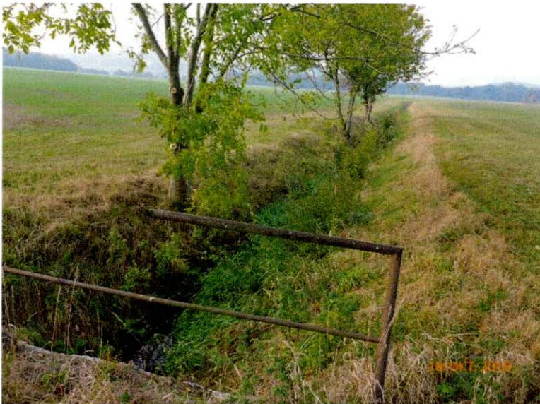
Foto 18: begradigter Kleinerkmannsdorfer Baches südwestlich des Feldweges mit Blick in Richtung Prießnitz
