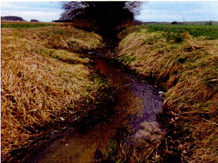
Abb. 23: Böschungen im 2. Einleitbereich – ohne Gehölze (Blickrichtung Westen)
