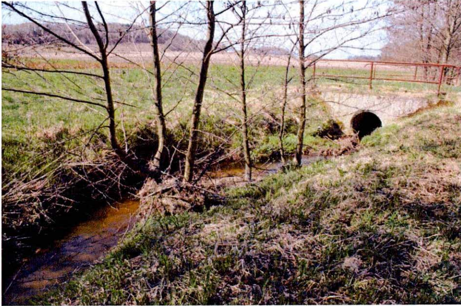
Abb. 10: Verrohrung des Gewässers auf kurzer Strecke
