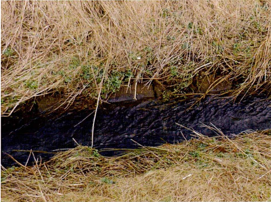
Abb. 15: Kleinerkmannsdorfer Bach mit Ufer- und Sohlbefestigung
