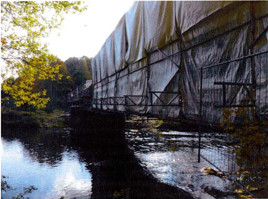
Abb. 14: Einhausung von Traggerüsten aus Gewässerschutzgründen
