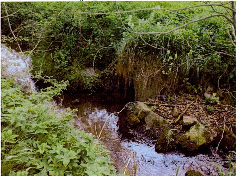
Abb. 3: Einmündung (Betonrohr) des Kleinerkmannsdorfer Baches in die Prießnitz-1
