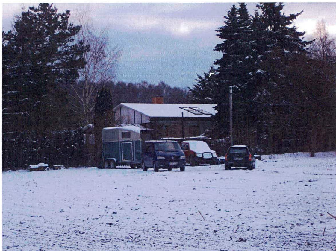
Bild 4 Dresden (Weißig), Bautzner Landstraße 360, Nordwest-Ansicht
