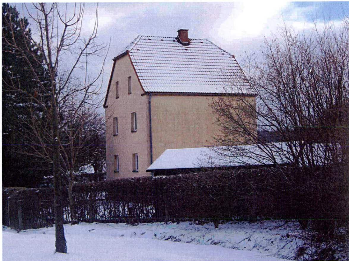
Bild 2 Dresden (Weißig), Bautzner Landstraße 350, Nordwest-Ansicht
