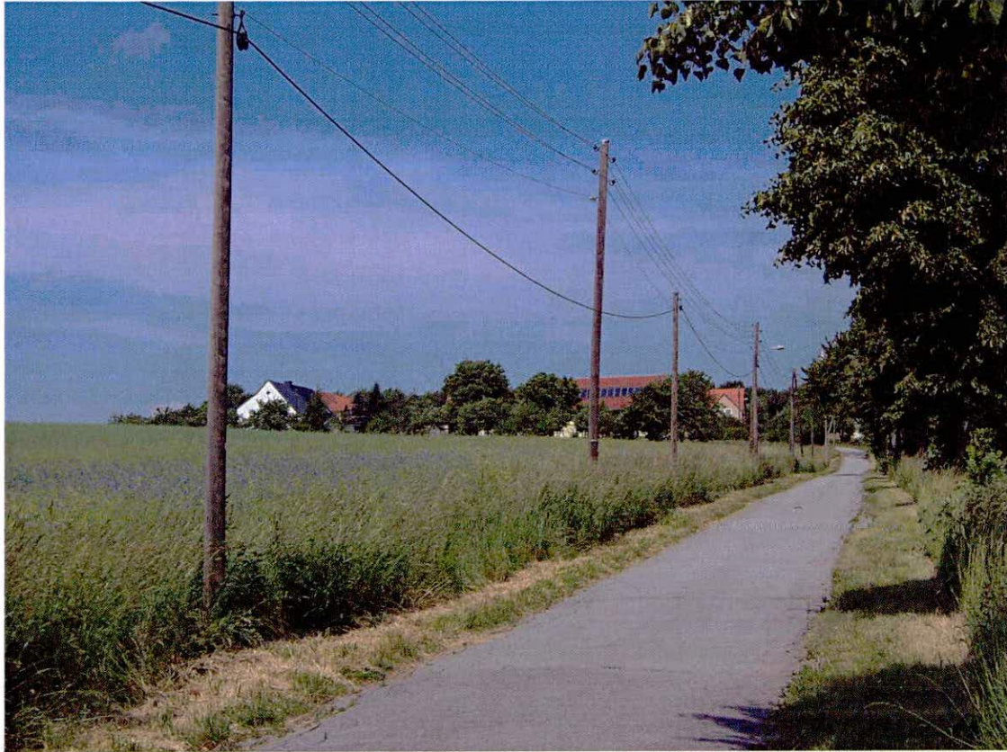
Bild 9 Dresden (Rossendorf), Gutsweg zu den Gebäuden Nr. 1 bis 4, Ost-Ansicht
