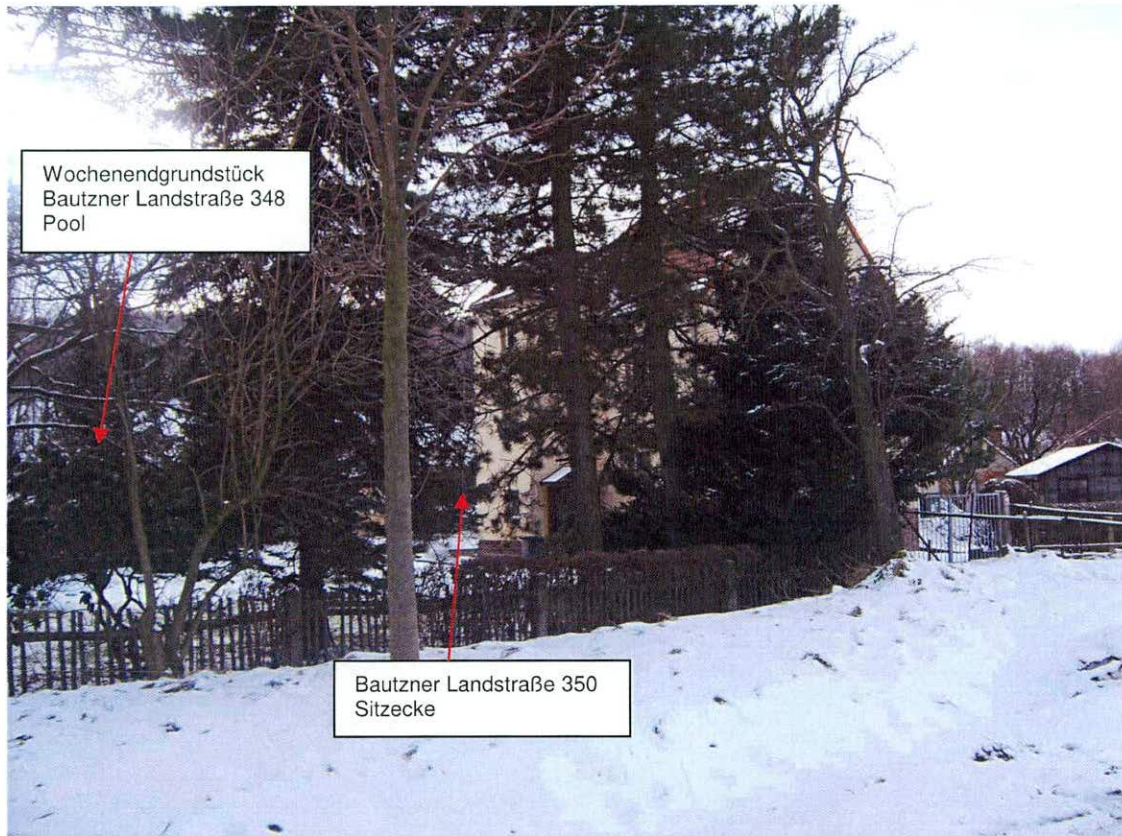
Bild 3 Dresden (Weißig), Bautzner Landstraße 350, Nordost-Ansicht
