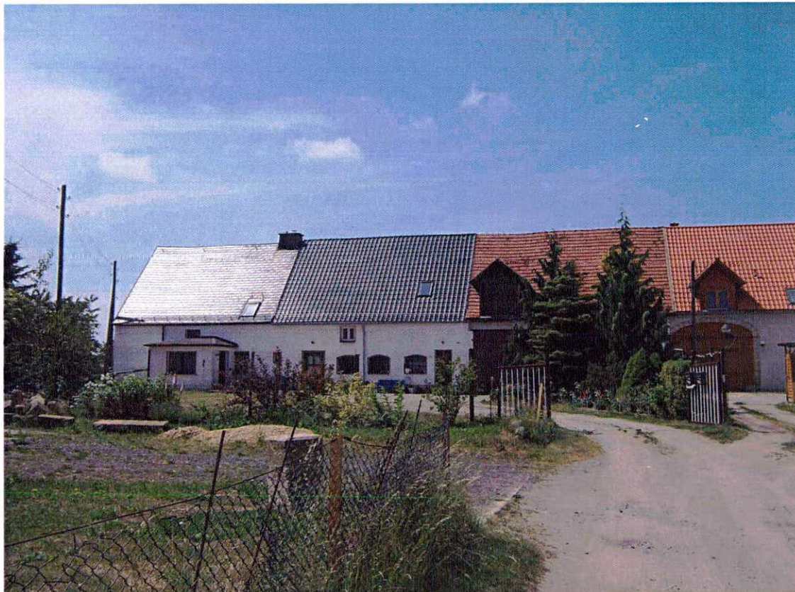
Bild 6 Dresden (Rossendorf), Gutsweg 2a, Nord-Ansicht
