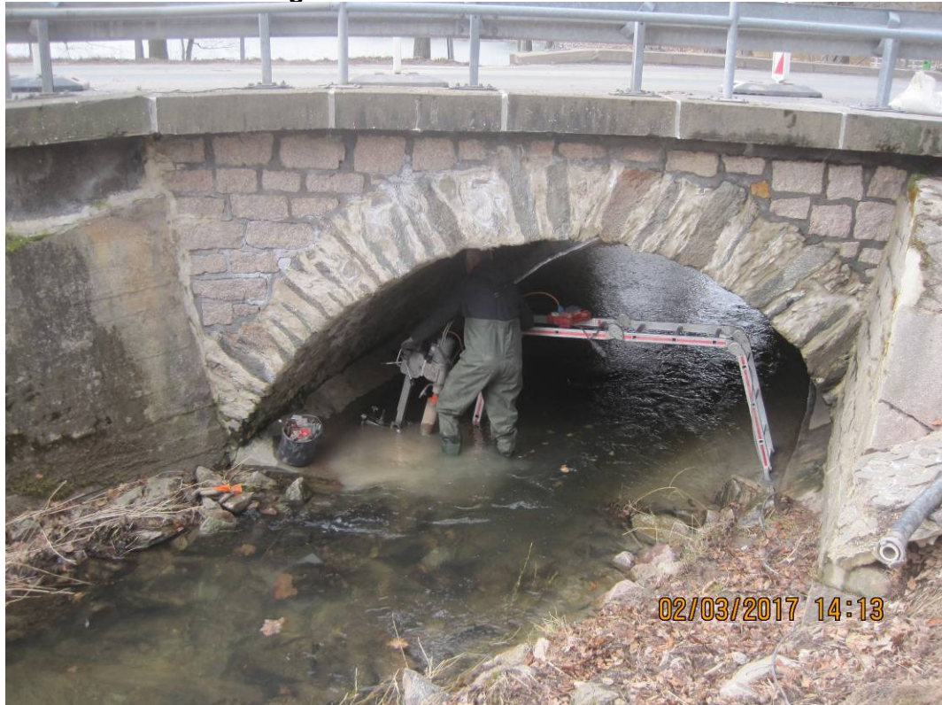
Foto 03: Bohrung KB 2S, Bohrpunkt
