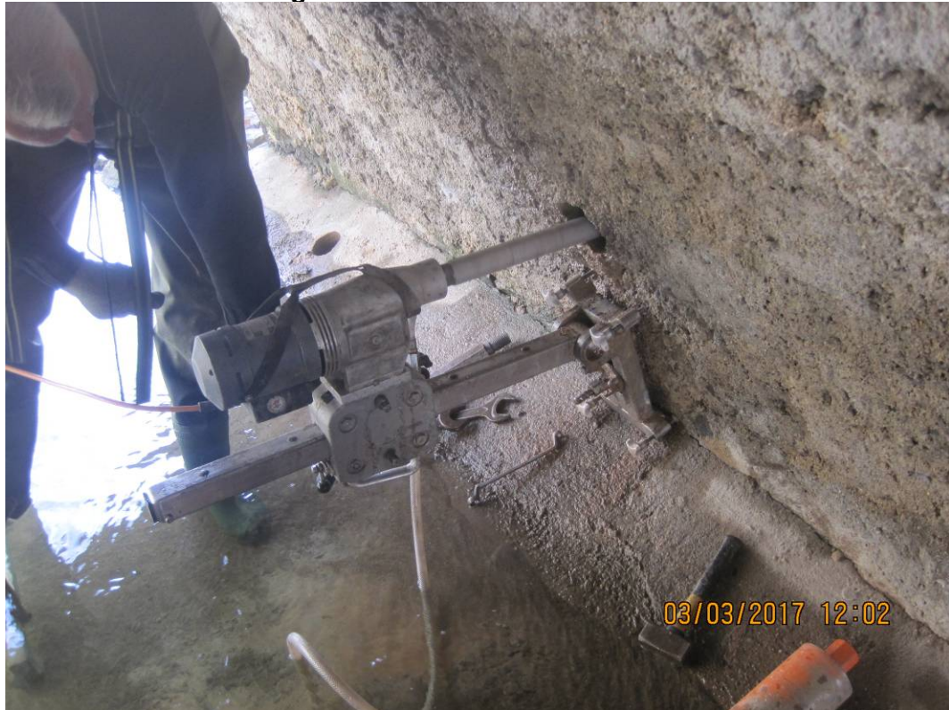
Foto 07: Bohrung KB 4H, Bohrpunkt
