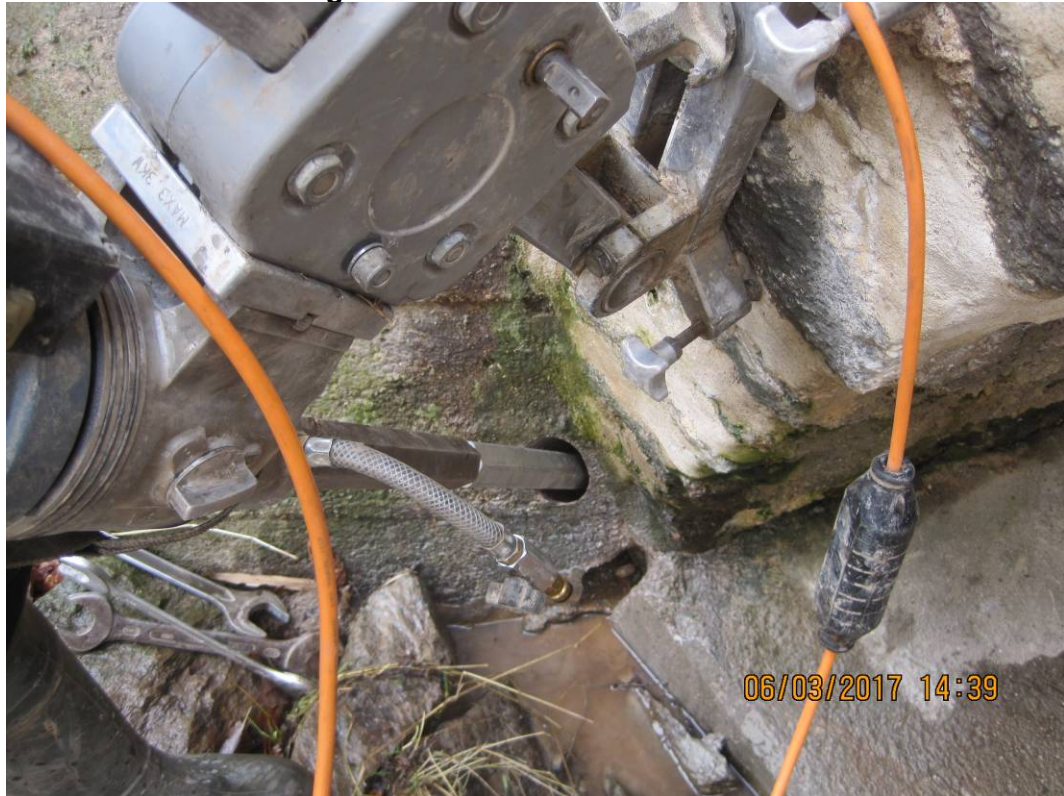
Foto 11: Bohrung KB 6S, Bohrpunkt
