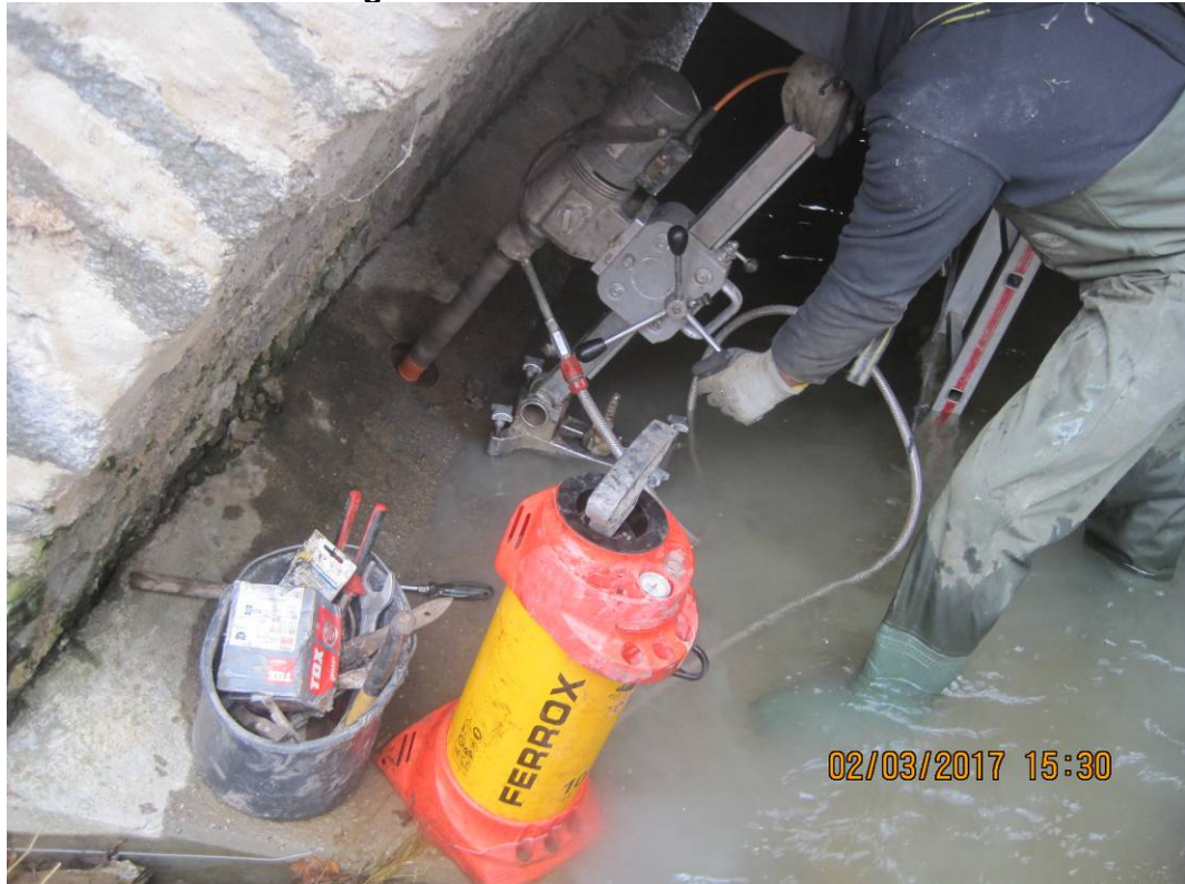
Foto 05: Bohrung KB 3S, Bohrpunkt
