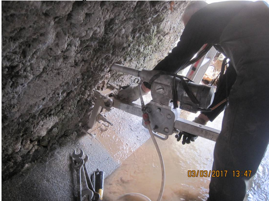
Foto 09: Bohrung KB 5H, Bohrpunkt
