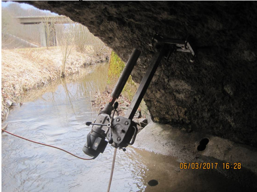
Foto 15: Bohrung KB 8S, Bohrpunkt
