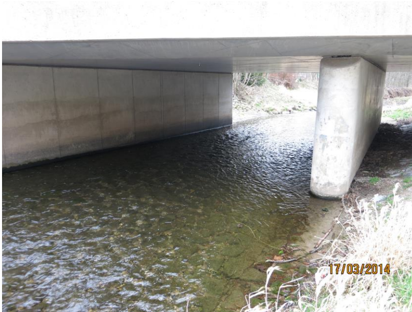
Bild 6: Brücke Klaffenbacher Hauptstraße (BW2), Wür- schnitz mit Sohlpflasterung, Ersatz durch oberflächen- rauen Steinsatz aus groß- formatigen Wasserbauste- nen
