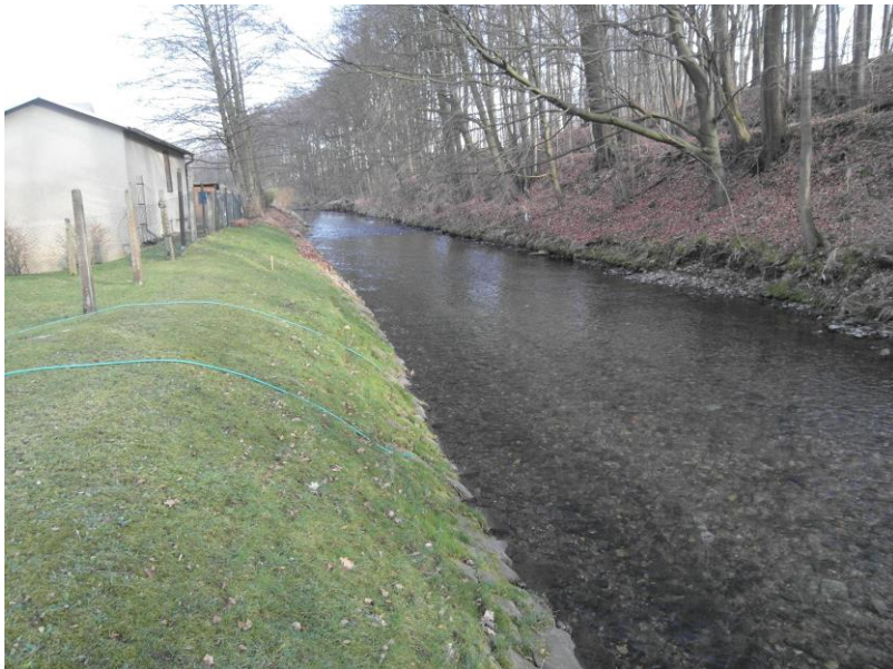
Bild 4: Würschnitz oberhalb Brücke Klaffenbacher Hauptstraße mit linksufrig vorhandener und weit in die Gewässersohle hineinragender historischer Uferbefestigung aus Setzpack
