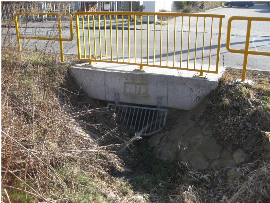
Foto-Nr. 16: Einlauf in den Durchlass des wild abfließenden Gewässers unter der Würschnitztalstraße, Blick in Richtung Würschnitz
