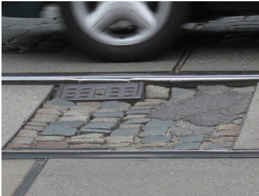
Abbildung 5: Gleisbereich mit schadhafter Gleiseindeckung
