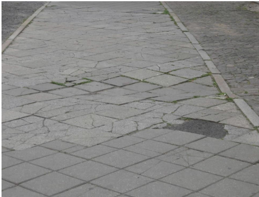
Abbildung 8: Gehweg mit schadhafter Befestigung
