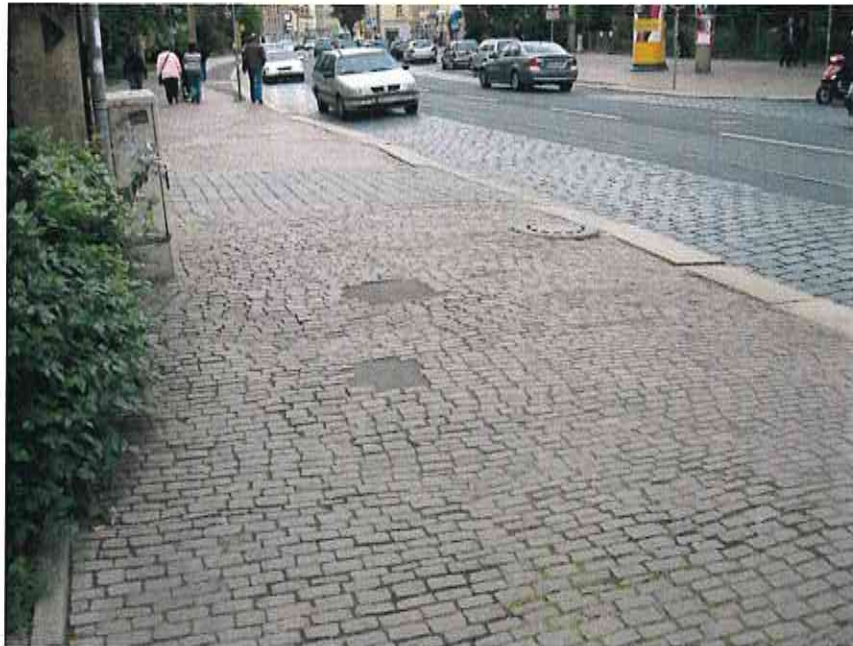
Abbildung 7: Gehwege entlang der Königsbrücker Straße
