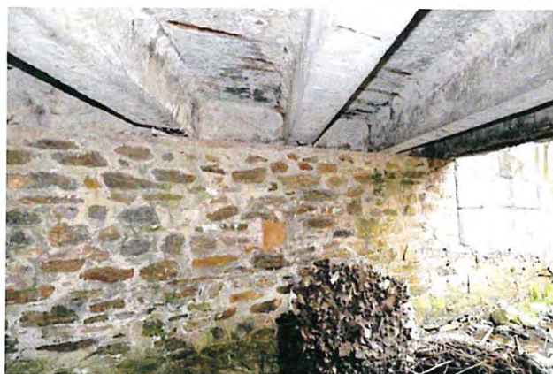
Foto 5: Brückenbauwerk BW 10 mit potenziellen Nischenstandorten
