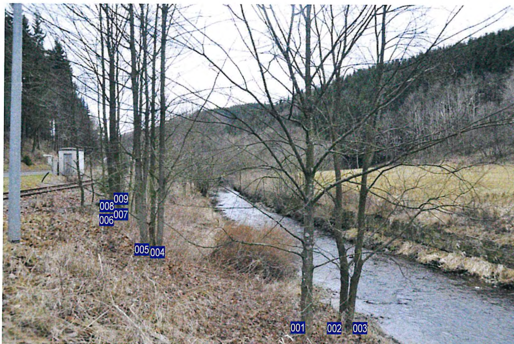
Foto 2: Ufergehölze unterhalb des BW 10
