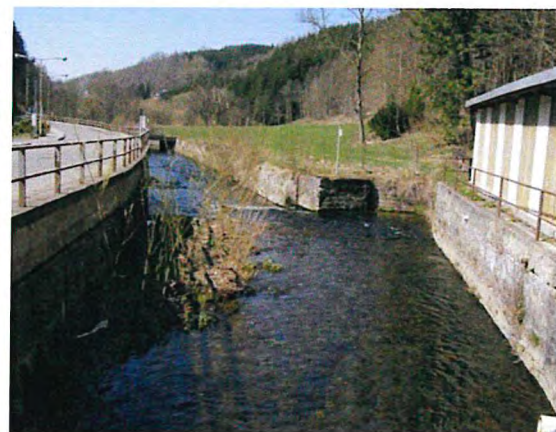
Foto 4: Flöha parallel der S 211 westlich des BW 8
