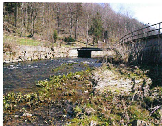
Foto 8: Flöha westlich der Brücke der ehemaligen Werkszufahrt mit LRT 6430 entlang der rechten Ufermauer
