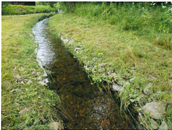
Foto 3: Östlicher Flutgraben mit Gesteinsschüttung
