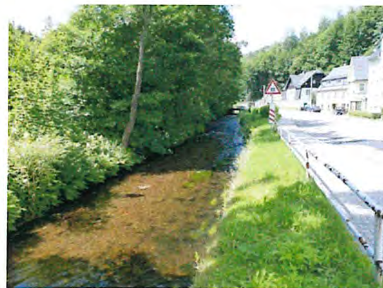
Foto 2: Flöha östlich des Brückenbauwerks 08 ohne Stützmauer
