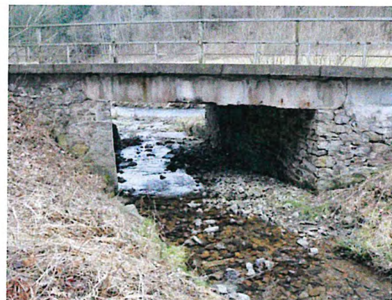
Foto 16: BW 10 am Mündungsbereich des Flutgrabens in die Flöha
