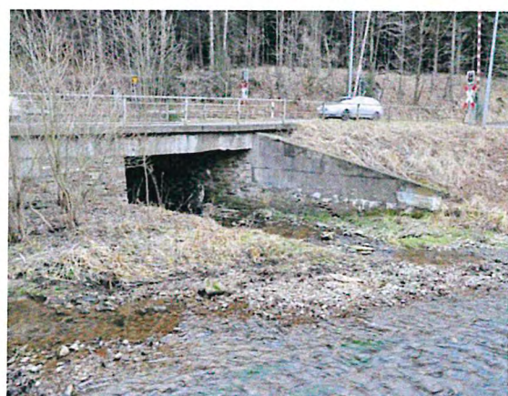
Foto 10: BW 10 mit Mündungsbereich des Flutgrabens in die Flöha sowie LRT 6430
