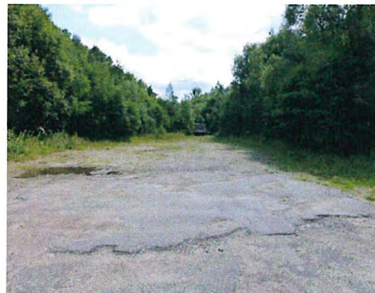
Foto 6: Übergangsbereich von versiegelter zu unversiegelter Parkplatzfläche mit Blick in Richtung Osten
