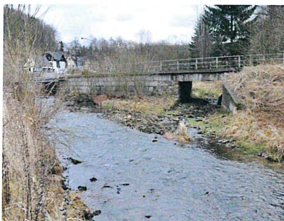
Foto 9: Flöha mit Blick stromaufwärts in Richtung BW 10 und LRT 6430
