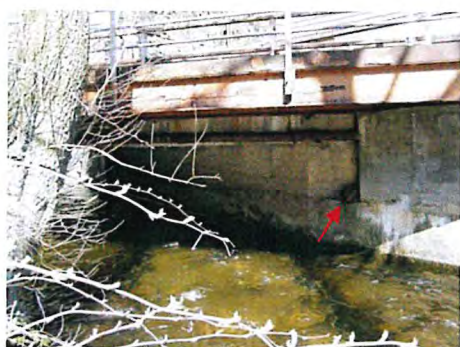
Foto 6: Brückenbauwerk BW 8 mit Wasseramselnest im Jahr 2010
