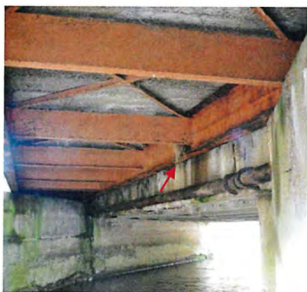
Foto 4: Brückenbauwerk BW 8 mit Neststandort der Wasseramsel 2013
