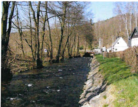
Foto 3: Flöha stromabwärts parallel der S 211 mit Blick auf BW 8
