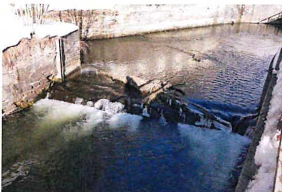
Foto 3: rückzubauendes Wehr in der Flöha (Blick stromaufwärts)
