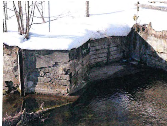
Foto 8: rückzubauende Stützmauer am Nordufer der Flöha
