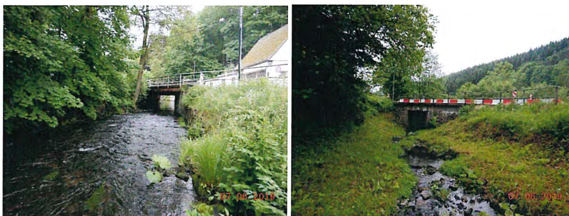
Foto 2: Links: Blick auf das BW 8 in Richtung Ortsausgang; Rechts: Blick auf das BW 10 in Richtung der Mündung in die Flöha
