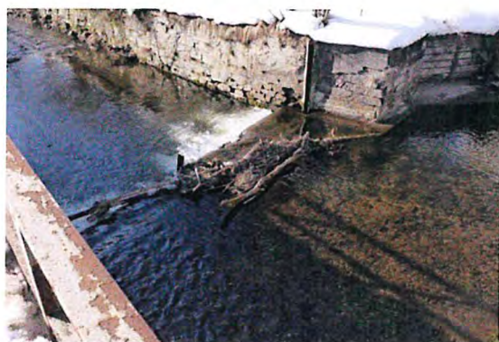
Foto 4: rückzubauendes Wehr in der Flöha (Blick stromabwärts)
