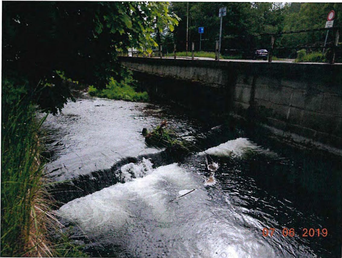
Foto 8: vorhandenes Wehr am Fluss-km 56,10
