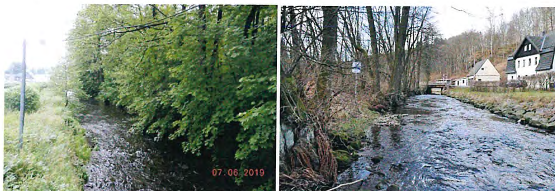
Foto 5: Flöha im Bereich der Ortslage links: mit Blick in Richtung Neuhausen, rechts: mit Blick auf das BW 8 im Januar
