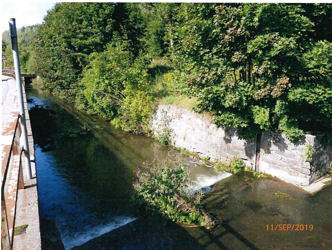
Foto 4: Lage das vorhandenen Wehres mit Blick flussabwärts
