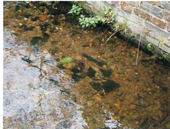
Foto 14: Vorkommen des Haken-Wassersterns ( Callitriche hamulata ) an der nördlichen Uferstützmauer westlich der Brücke BW 8
