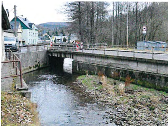
Foto 1: Ufermauer der S 211 mit BW 8 und Schotterbank in der Flöha
