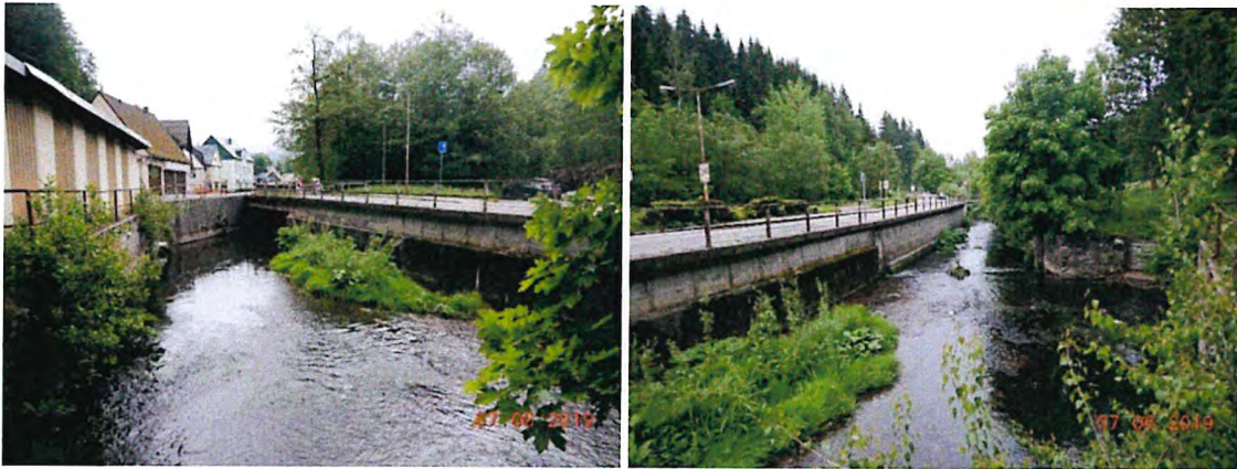
Foto 6: links: Flöha mit Blick auf das BW 8 und die S 211; rechts: Blick auf das Wehr und das BW 6 entlang der S 211 sowie die Kies- / Schotterbank
