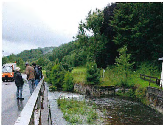
Foto 12: Gewässerbegleitende Gehölze im Bereich der nördlichen Ufermauer im Sommer
