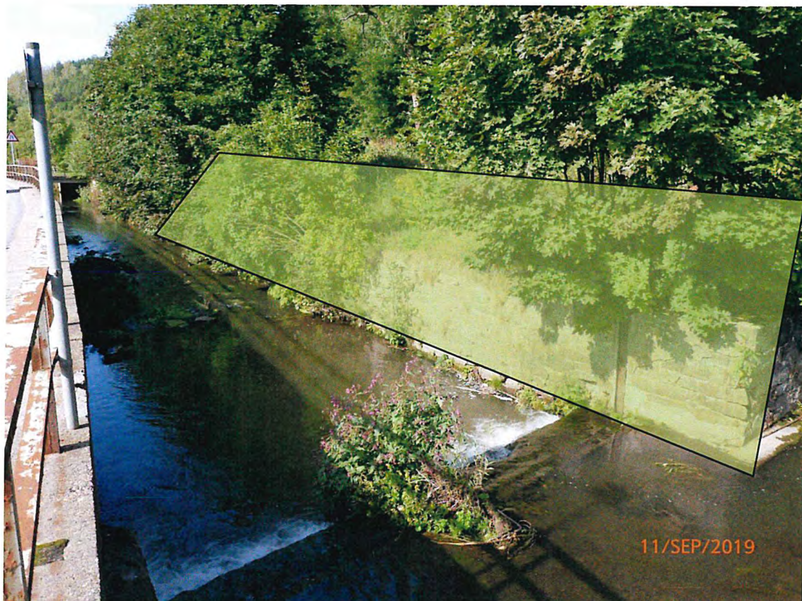
Foto 10: Rückbau der bestehenden Stützmauer und Anlage einer begrünter Uferböschung mittels ingenieurbioologischer Sicherungsbauweisen durch die Ausgleichsmaßnahme 10 A und 10.1 A (Begrünte Steinschüttung und Steckling auf Kokosgewebe)
