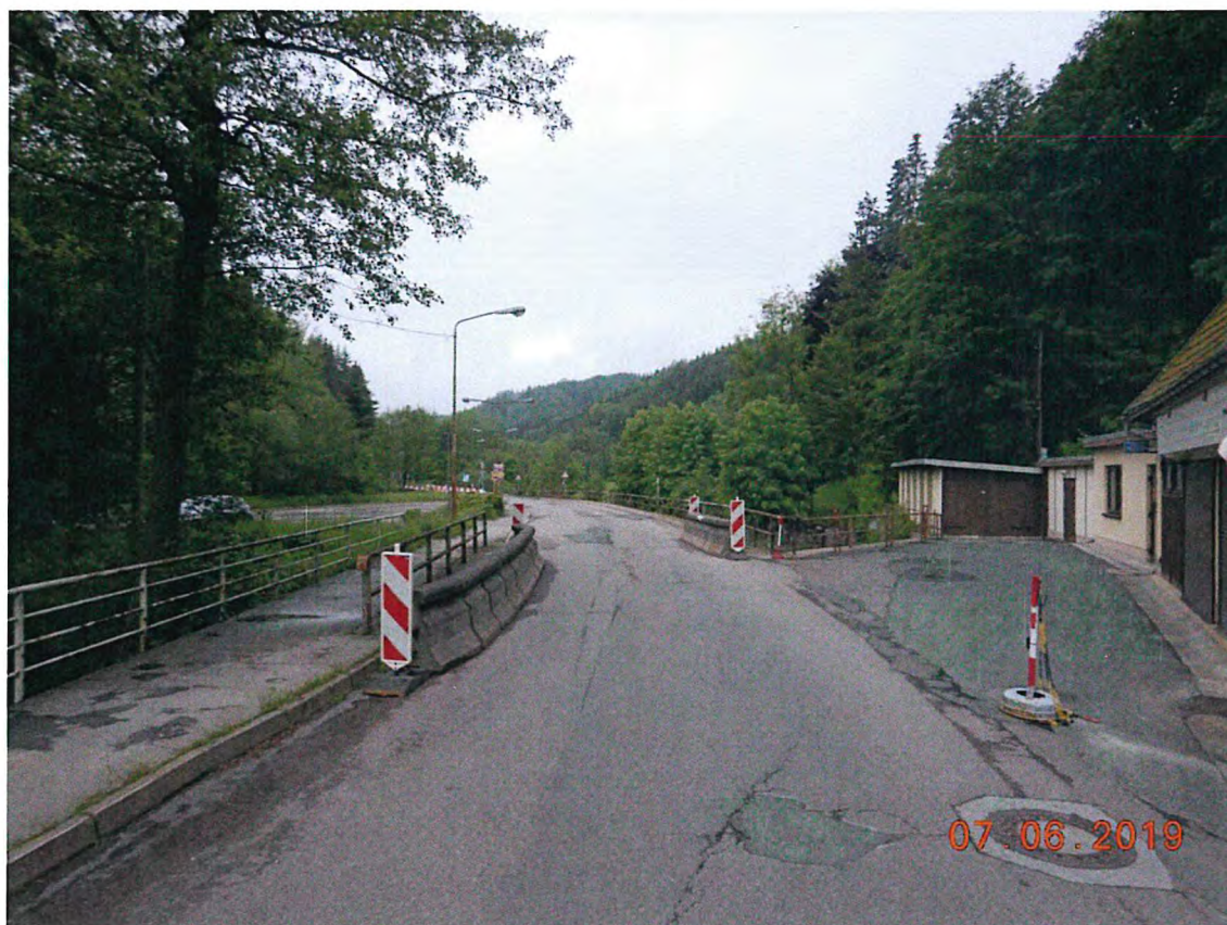
Foto 1: Die Brücke (BW 8) über die Flöha mit Blick in Richtung Ortsausgang.
