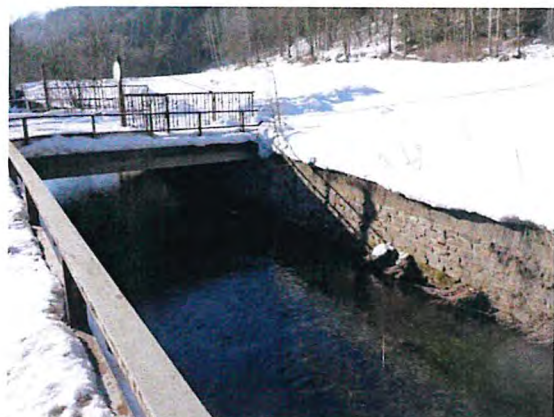
Foto 2: ehemalige Werkszufahrt stromabwärts der Wehranlage
