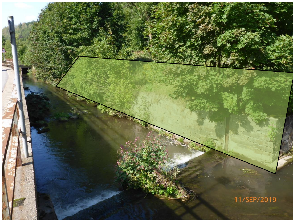
Foto 10: Rückbau der bestehenden Stützmauer und Anlage einer begrünten Uferböschung mittels ingenieurbioologischer Sicherungsbauweisen durch die Ausgleichsmaßnahme 10 A und 10.1 A (Begrünte Steinschüttung und Steckling auf Kokosgewebe)
