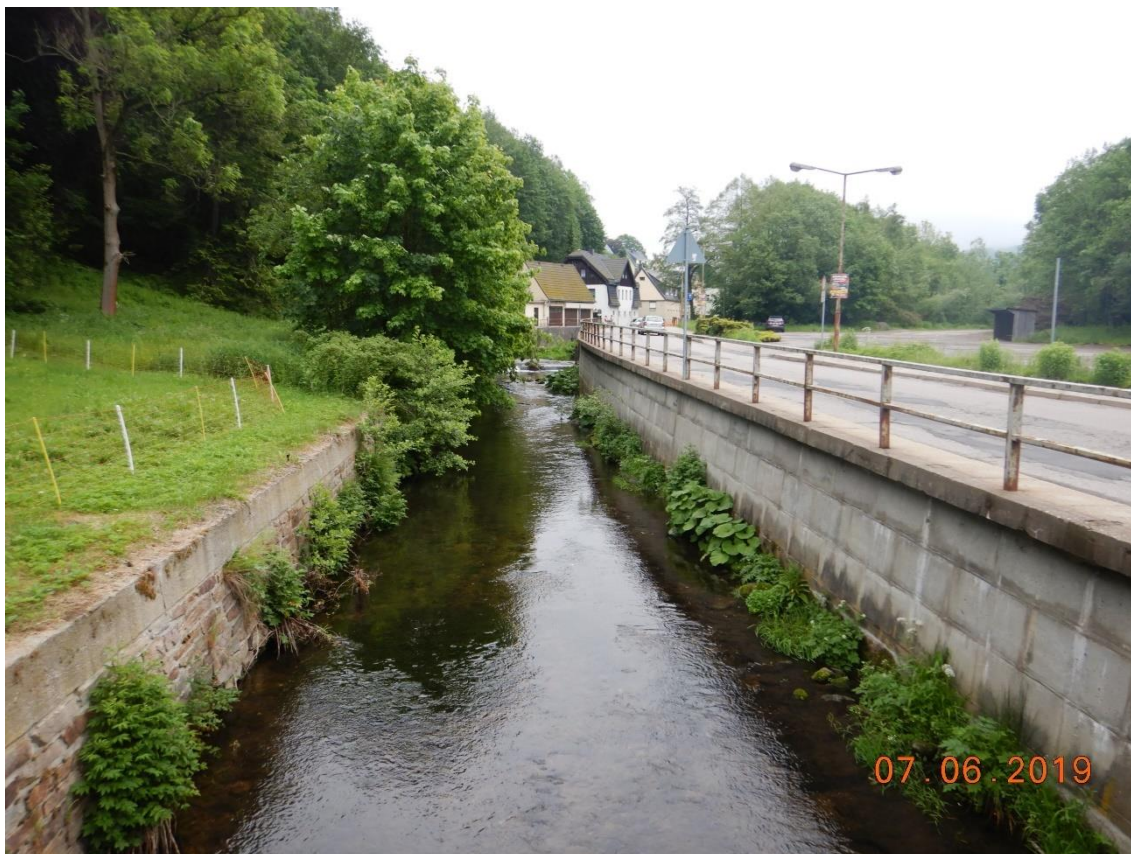
Foto 3: Blick stromaufwärts mit dem vorhandenen BW 6, der herabzusetzenden Stützmauer (rechts) und der zu errichtenden Uferböschung im Zuge des Wehrrückbaus (links)
