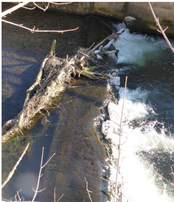
Foto 5: Querriegel aus Beton mit vorgelagerter Metallbefestigung
