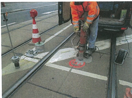
Bild 3: Ausführung der Kernbohrung - KRB 5 i
