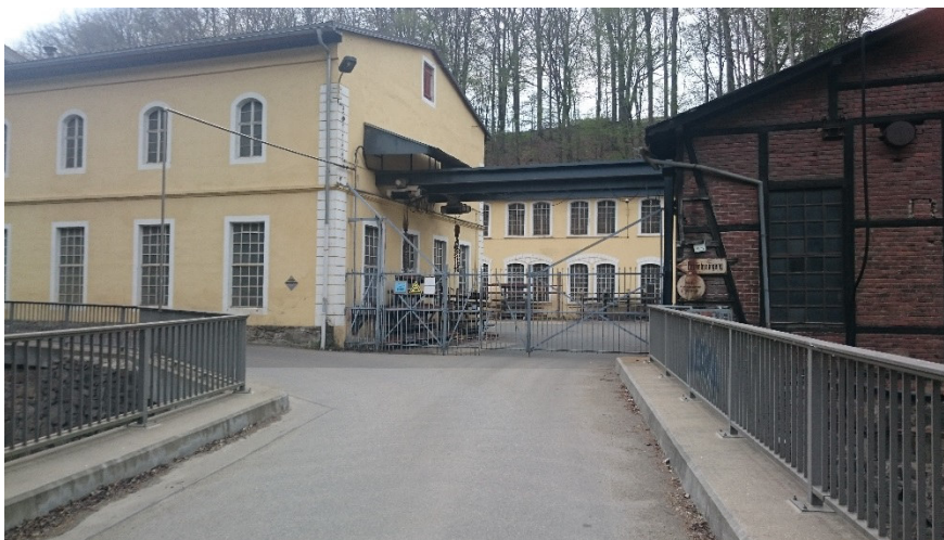
Foto 7: Hofmeister Maschinen und Stahlbau GmbH (Fabrikgelände Hammerwerk)
