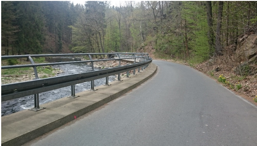
Foto 8: Kurvenbereich mit Leitplanken
