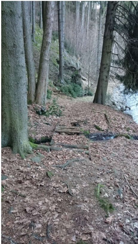
Foto 3: zerstörter Steg in Schadensbereich 5
