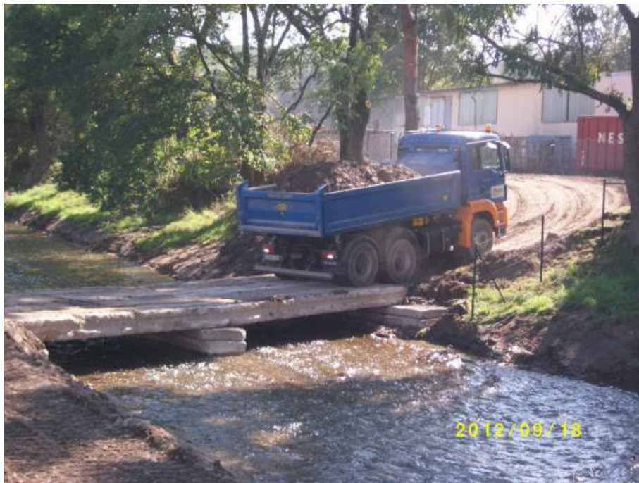
Foto 12: Beispiel aufgelöste Baustraße
