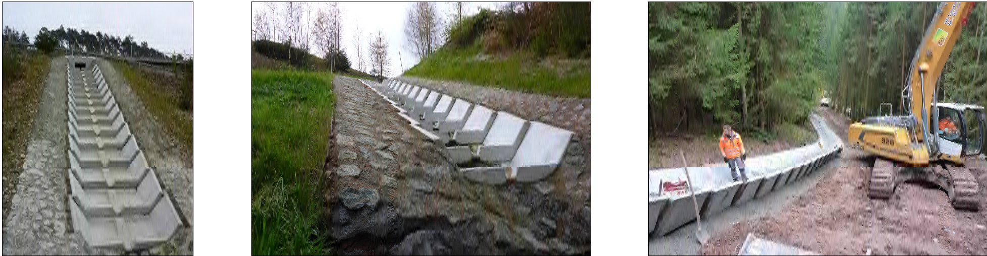
Ausführungsbeispiel Kaskade mit Verlegung in Beton Fotos: Fa. Pfeifenbring
