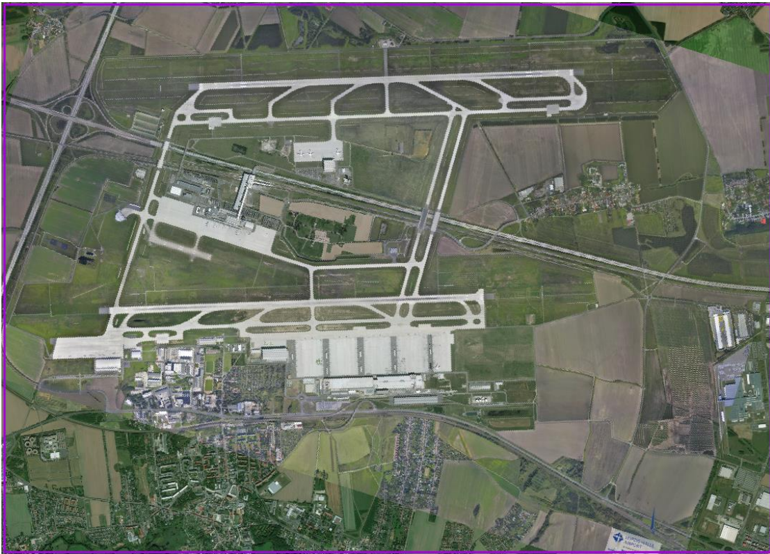
Abb. 2: Das Untersuchungsgebiet Flughafen Leipzig / Halle im Ist-Zustand (Luftbild: Digitales Orthophoto 2018)
