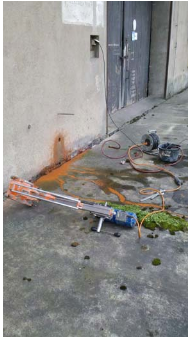
Kernbohrung Außenwand Schuppen C
