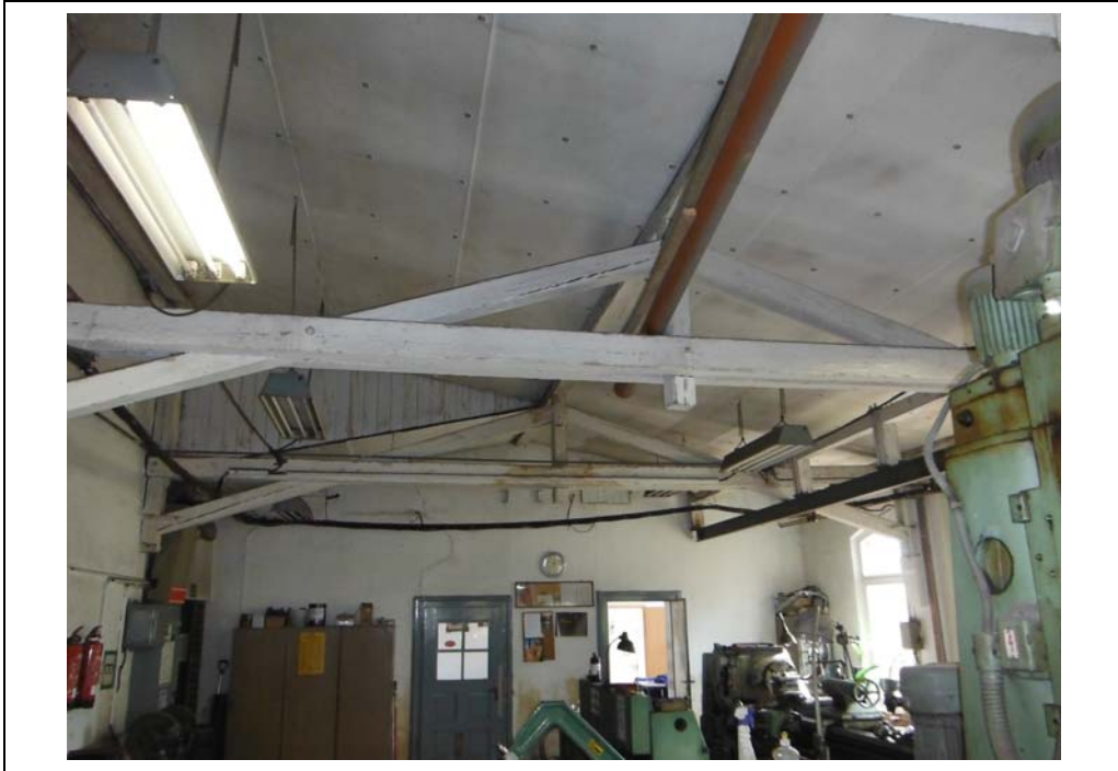
Blick die Asbestdeckenverkleidung im Werkstattbereich
