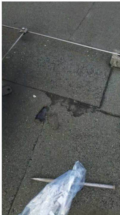
weitere Probenahmestelle Dachpappe Werkstattgebäude
