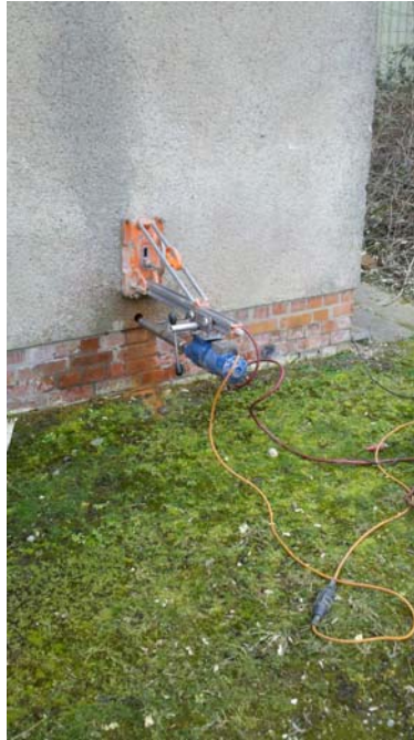
Kernbohrung nördliche Außenwand
