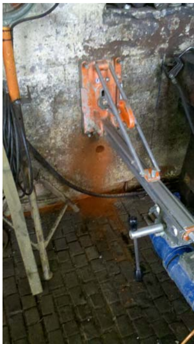
Kernbohrung Innenwand Schmiede / Werkstatt
