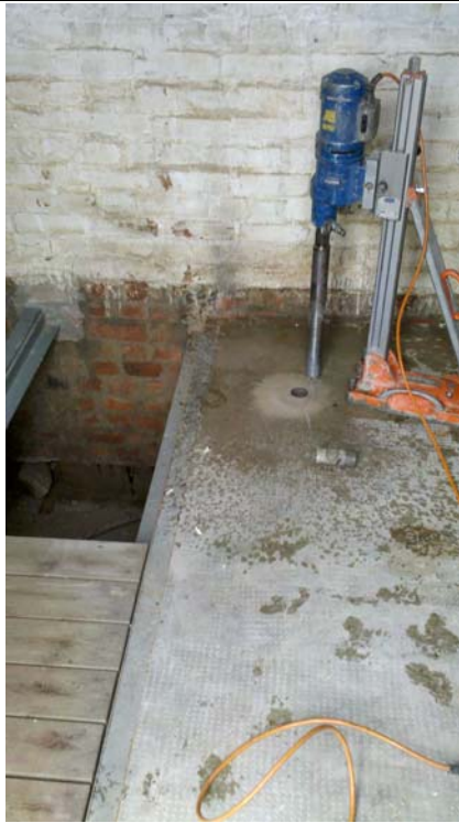
Kernbohrung Fußboden
