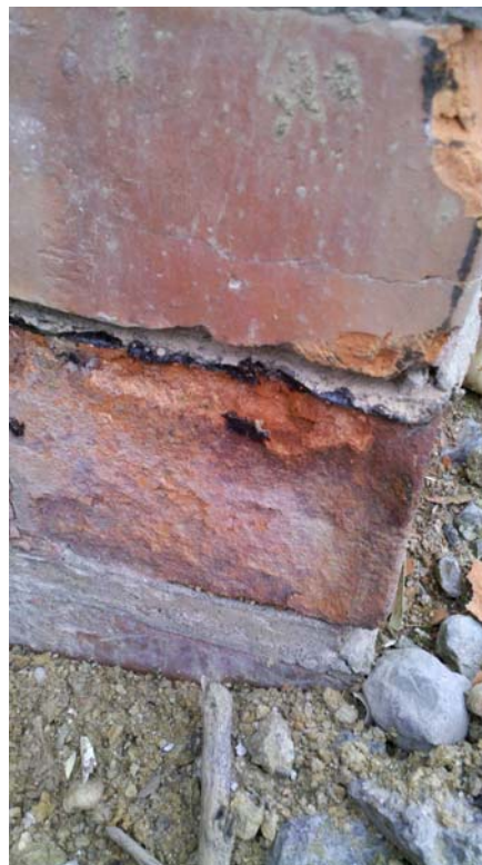
Probenahme Sperrschicht Außenwand Trafogebäude
