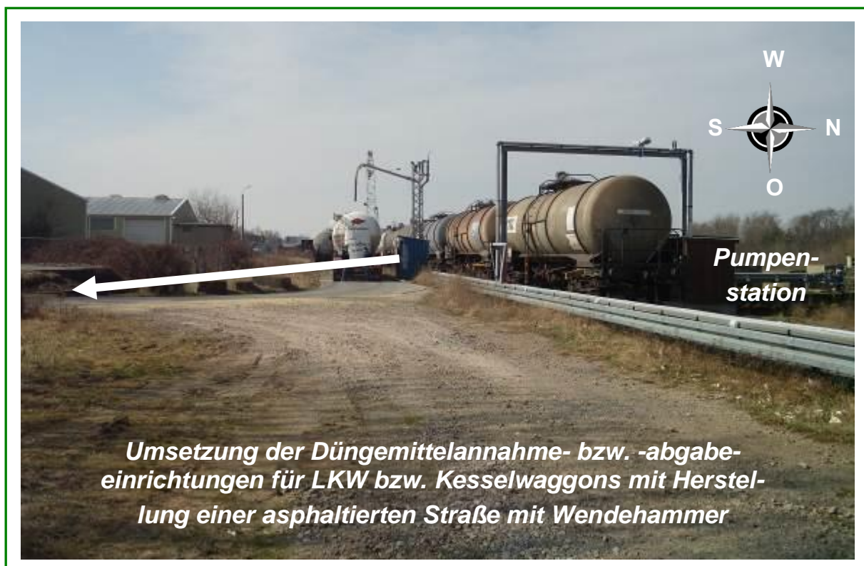
Bild 23: Düngemittelannahme- bzw. -abgabeeinrichtungen für LKW bzw. Kesselwaggons
