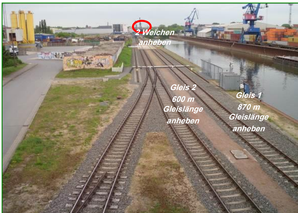
Bild 25: Ansicht Gleis- und Weichenanhebungen Gleise 1 u. 2
