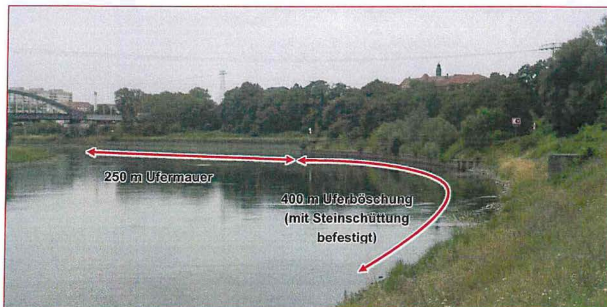
Abbildung 4.10: Linke Uferlinie der Elbe mit Befestigung (Blick vom nördlichen Ende des Planungsgebietes nach Stromauf)
