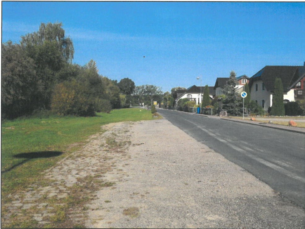
Bild 1: Das Bild zeigt rechter Hand eine Parkfläche sowie das Hotel Seehof Döllnitzsee. Die Fahrbahn soll im Bereich der bestehenden Trasse erneuert werden. Auf der Rasenfläche ist die Anlage eines straßenparallelen Radweges geplant. Fotostandpunkt etwa bei Bau-km 0+180,000 m (September 2017).
