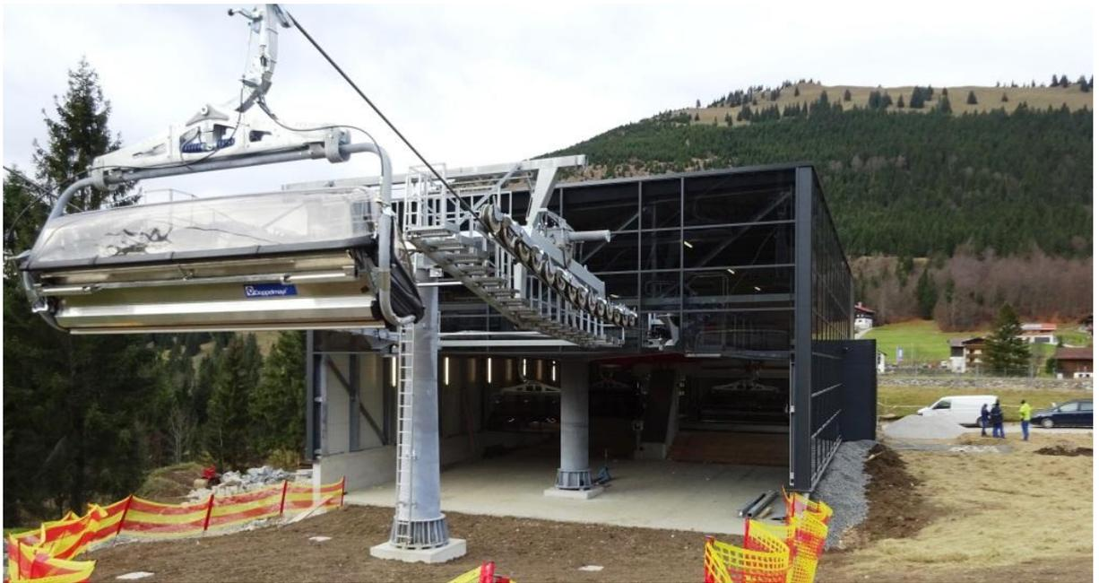
**Abbildung 12: Möglicher Lösungsansatz, Talstation kuppelbare Achtersesselbahn, Skigebiet Oberjoch – Ein-/Ausfahrtsbereich Sesselbahn (Schweiger)**
