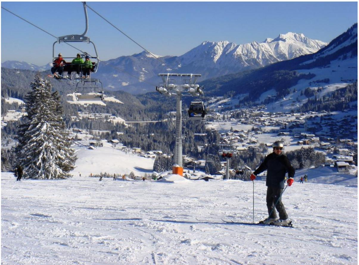
**Abbildung 7: Kombibahn mit Vierersessel und Kabinen**
