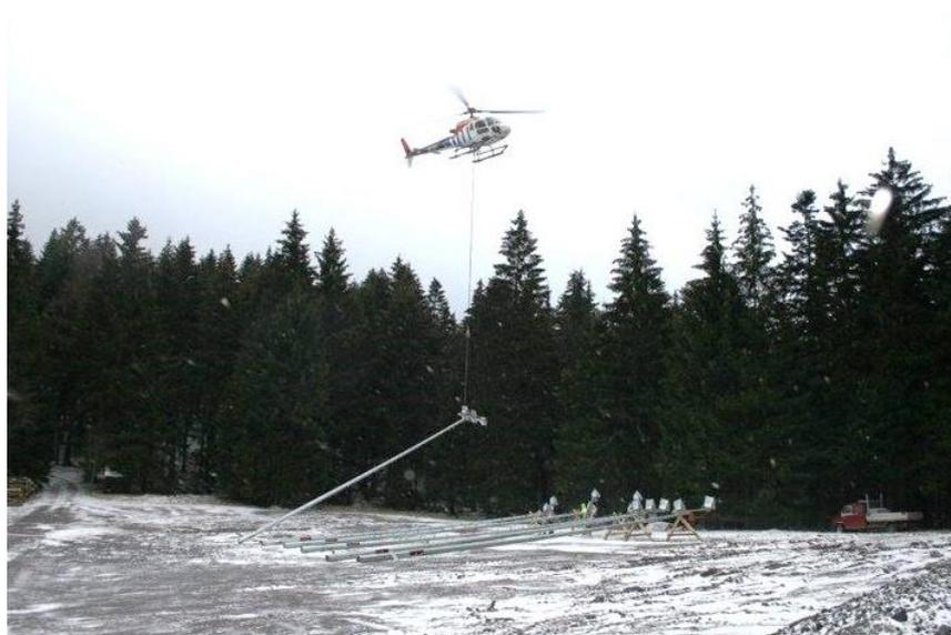
**Abb. 29: Montage Beleuchtungsmasten mit Hubschrauber**
