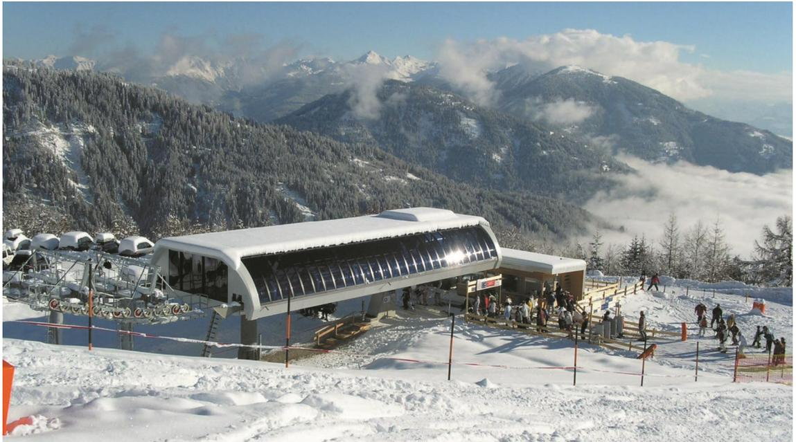
**Abb. 13: Kuppelbare Sesselbahn ohne Seilbahngebäude, jedoch mit Einhausung der seilbahntechnische Ausrüstung**
