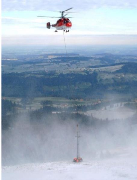
**Abb. 27: Stützenmontage mit Hubschrauber, Traglast 4,8 to**
