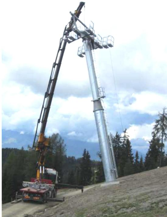
**Abb. 26: 4-Achs-LKW mit Ladekran bei der Stützenmontage**
