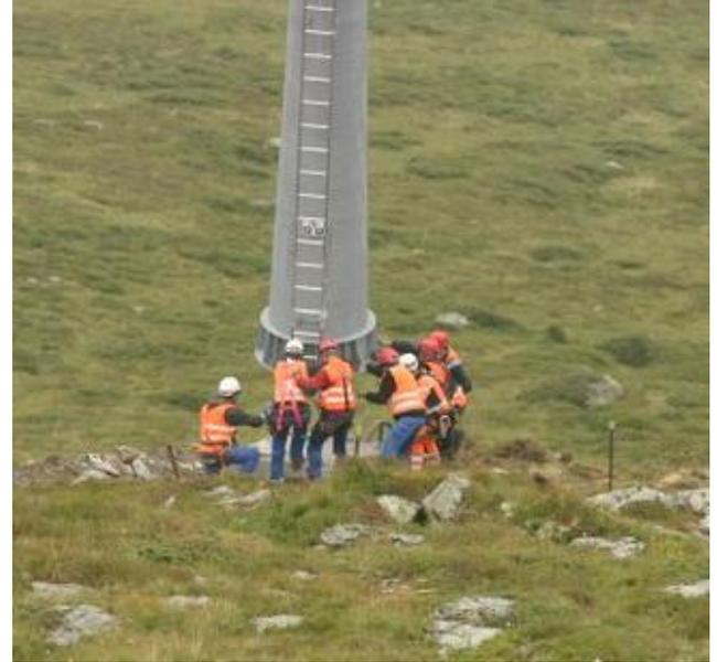
**Abb. 28: Stützmontage mit Hubschrauber, Montage am Boden**
