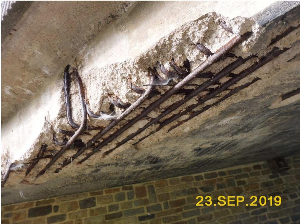
BILD 06 - ZUSTAND DER STAHLBETONPLATTE OBERSTROMIG
