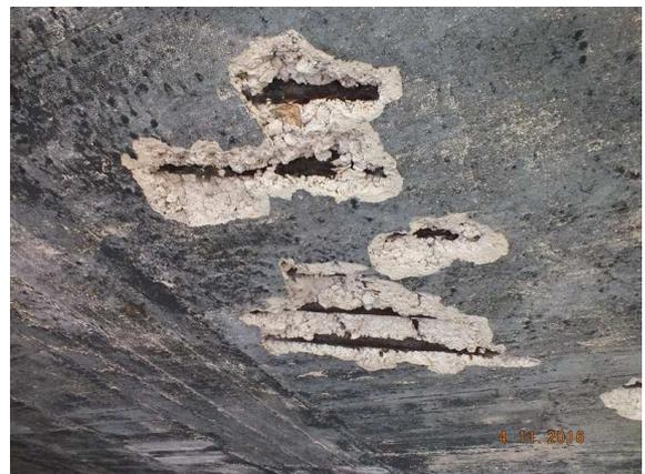
2016H ABPLATZUNGEN UNTERSEITE FREILIEGENDE EISEN MINDERFESTER BETON
