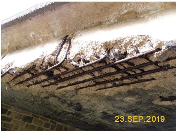
EP 2019 - BILD 01 - MÜRBER ÜBERBAUBETON
