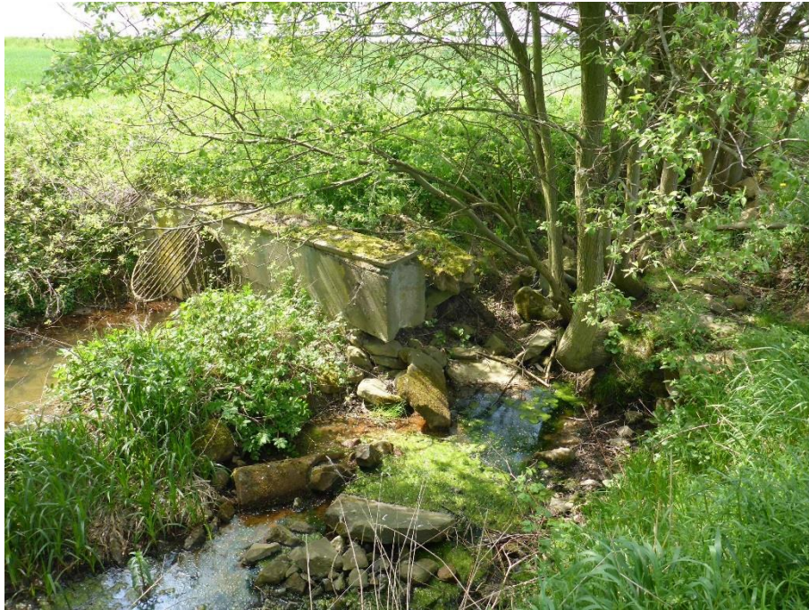
Foto 1: Übergang des offen fließenden Krebsbaches zum verrohrten Abschnitt
