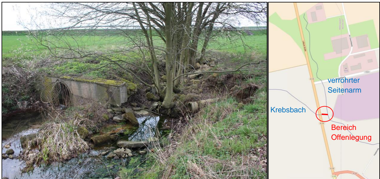
Abbildung 6: Auslauf Verrohrung Krebsbach im Bestand, Darstellung Offenlegungsbereich und Verlauf des verrohrten Seitenarmes (DN 300)
