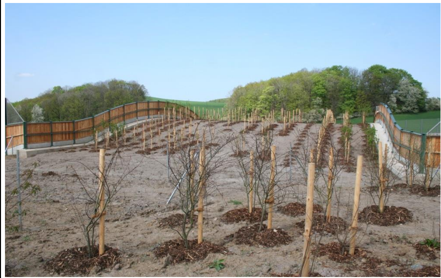
Foto 8: Grünbrücke mit Blend- und Irritationsschutzwänden
