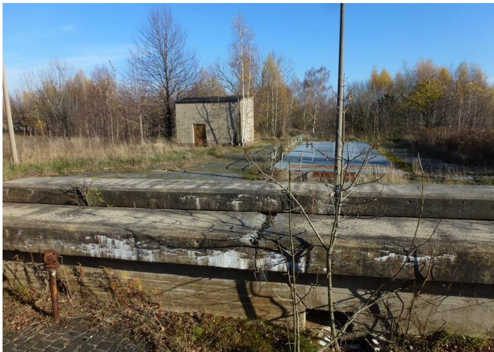
Foto 15: Ehemalige Waschanlage bestehend aus Panzerwaschrampen und Absetzbecken sowie der Pumpstation: Objekt 169 (Gebäude 9) im Hintergrund
