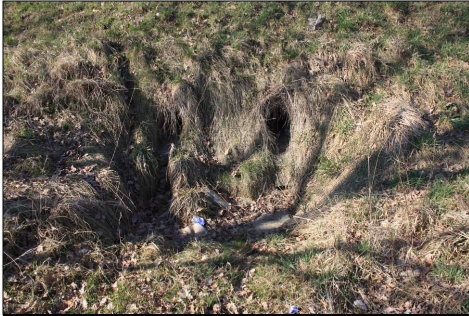
Abbildung 7: Auslauf Durchlass 2 x DN 300 im Geländetiefpunkt nördlich der K 8617
