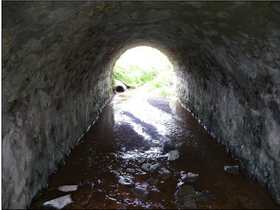
Abbildung 14: Gewölbedurchlass im Zuge der B 178, Durchleitung Krebsbach
