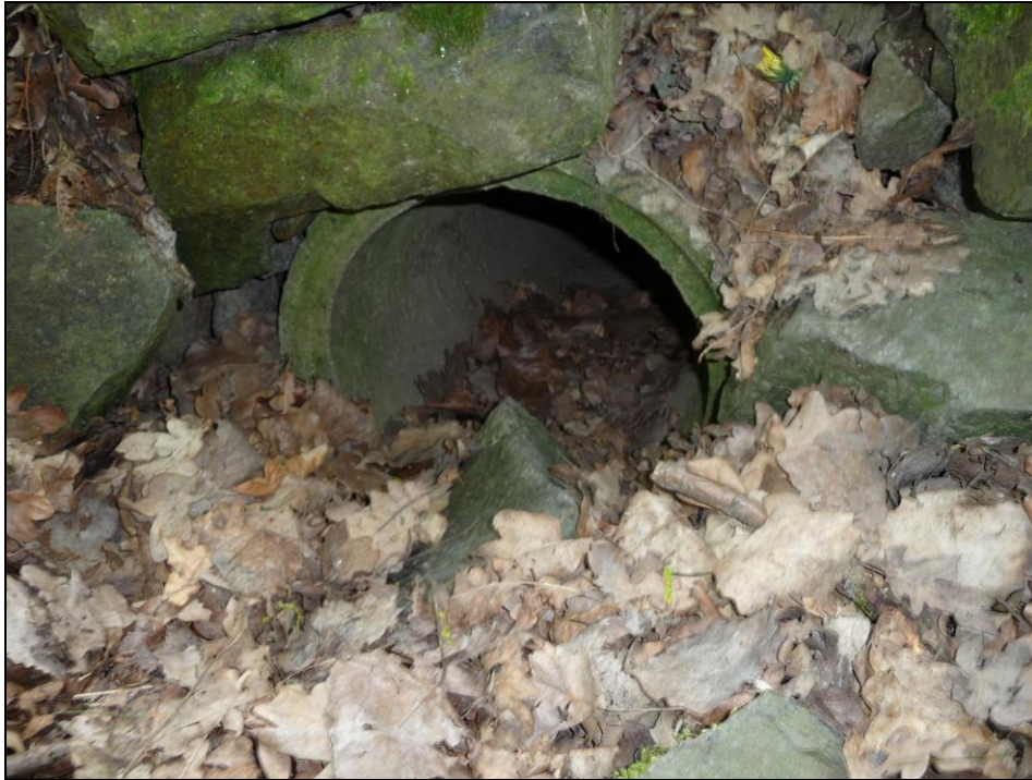
Abbildung 4: Rohreinlauf im südlichen Graben des Grenzweges
