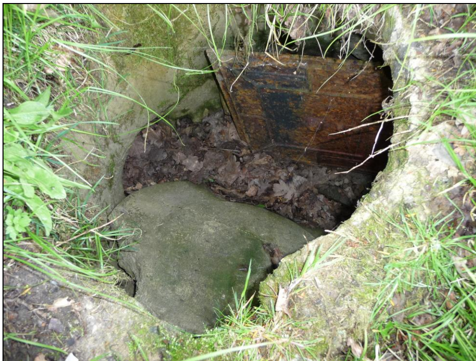
Abbildung 3: Einlaufschacht im nördlichen Graben des Grenzweges
