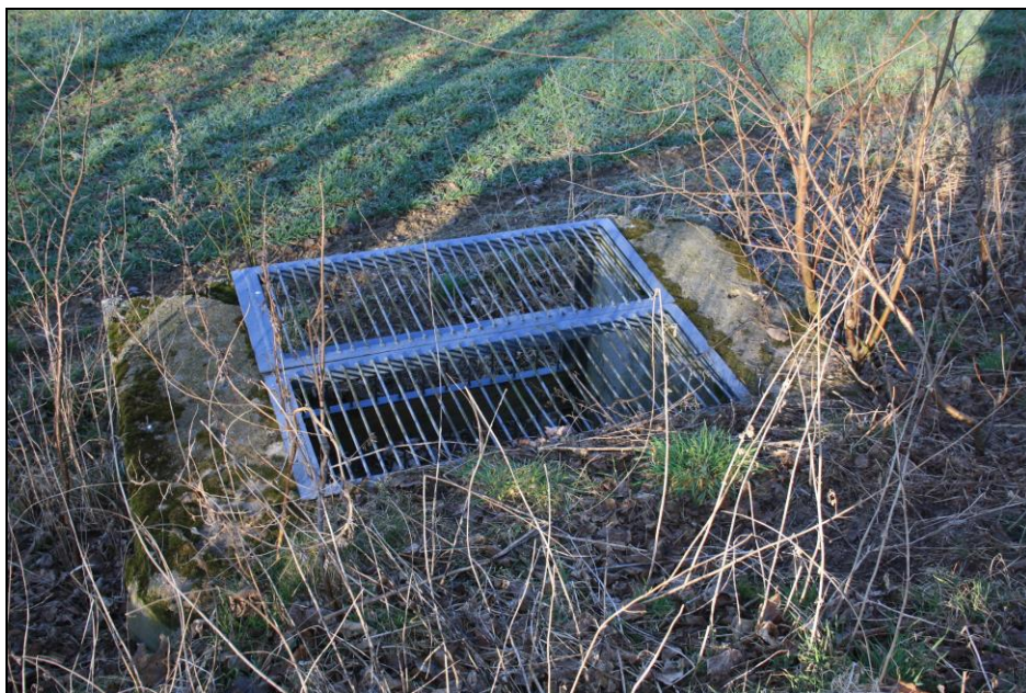
Abbildung 5: Einlaufbauwerk am Weg zum Steinberg
