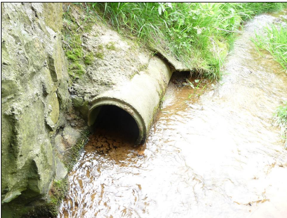
Abbildung 13: Auslauf einer Verrohrung DN 300 in den Krebsbach unmittelbar vor Durchlass B 178
