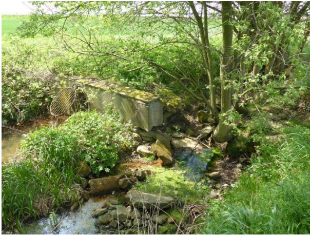
Foto 38: Auslaufbauwerk am Beginn des offen liegenden Krebsbaches
