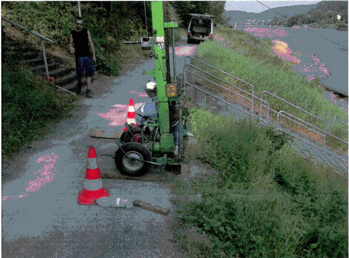
Bild 33: Schwere Rammsondierung DPH 165
