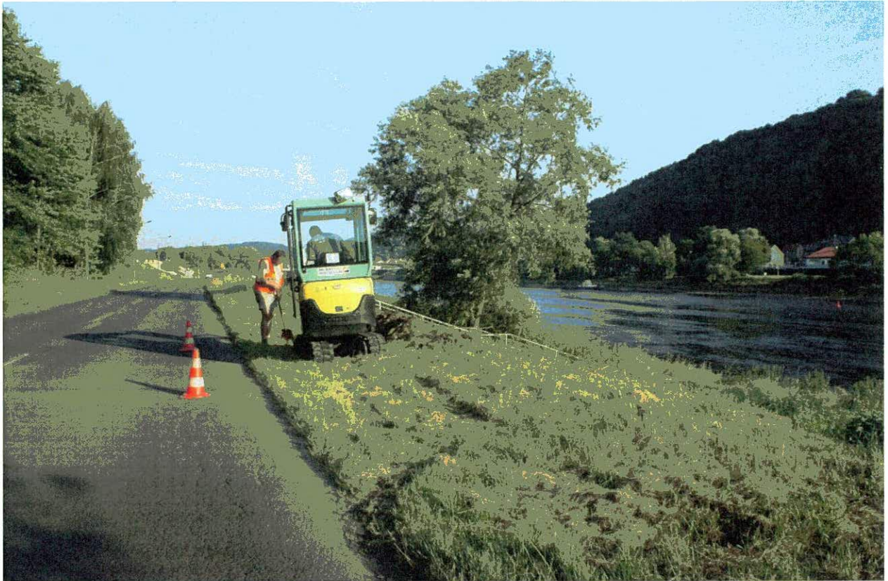
Bild 11: Lage Baggerschurf Sch/BS 75
