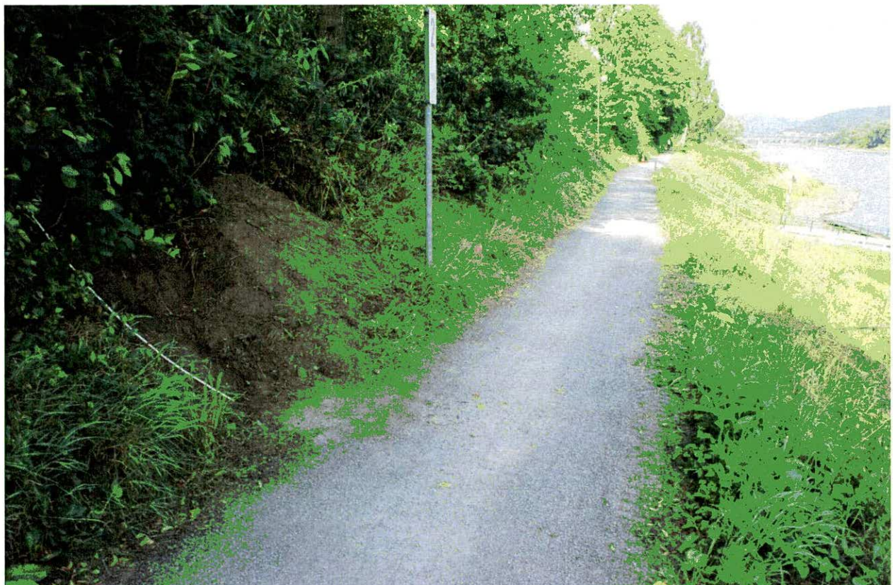
Bild 4: BSch 2, Blickrichtung Norden
