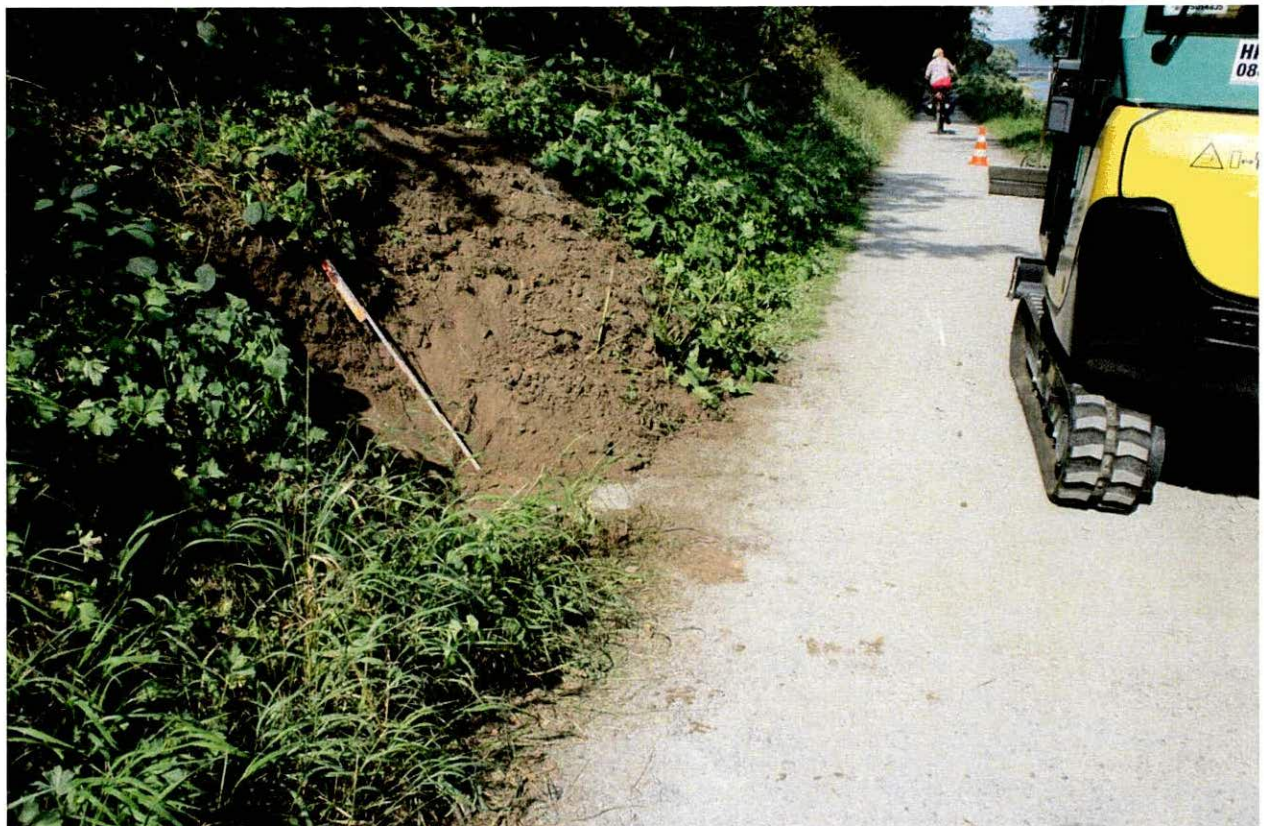
Bild 1: BSch 1, Blickrichtung Norden
