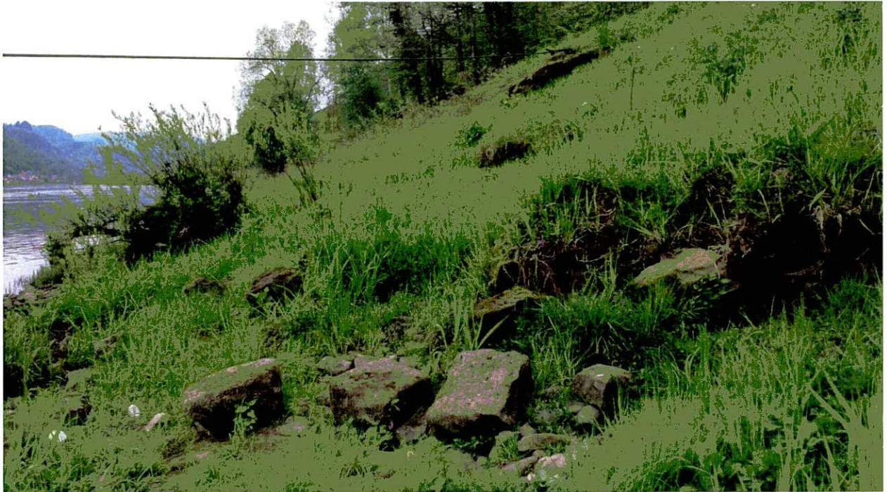
Bild 37: Zerstörte Böschungsbefestigung
