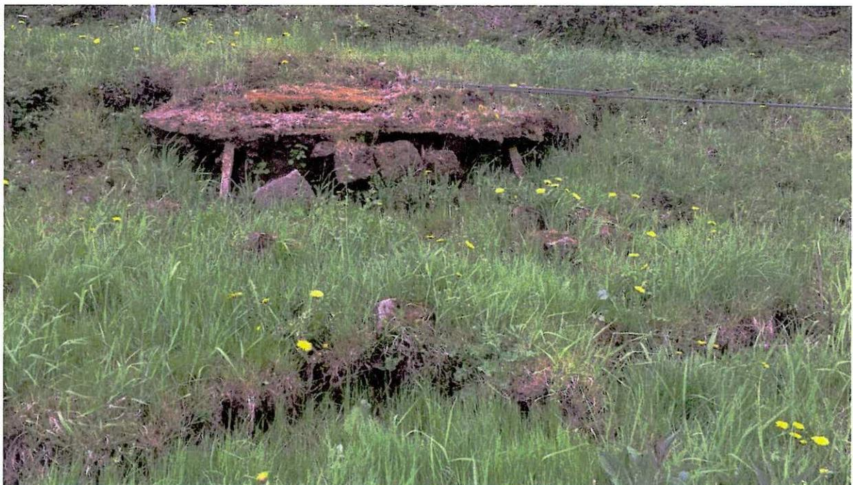
Bild 38: Rutschungen und Freispülungen an der Anlegerbefestigung
