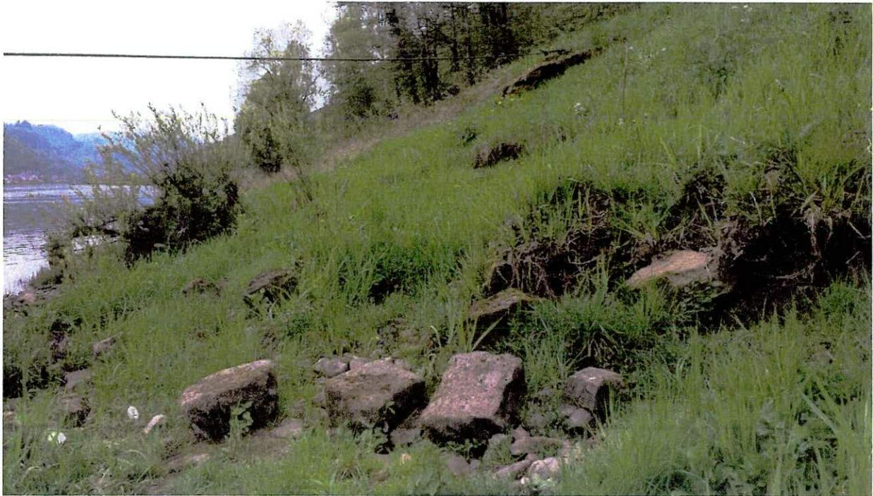
Bild 37: Zerstörte Böschungsbefestigung
