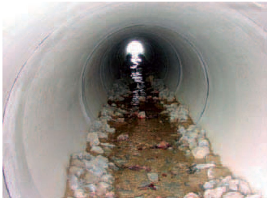
Abbildung 10: Beispiel für einen fischottergerechten Rohrdurchlass
