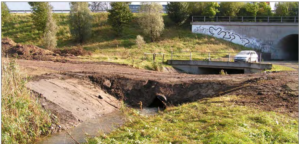
Abbildung 2: Bsp.: Gewässerüberfahrt mittels temporärem Rohrdurchlass
