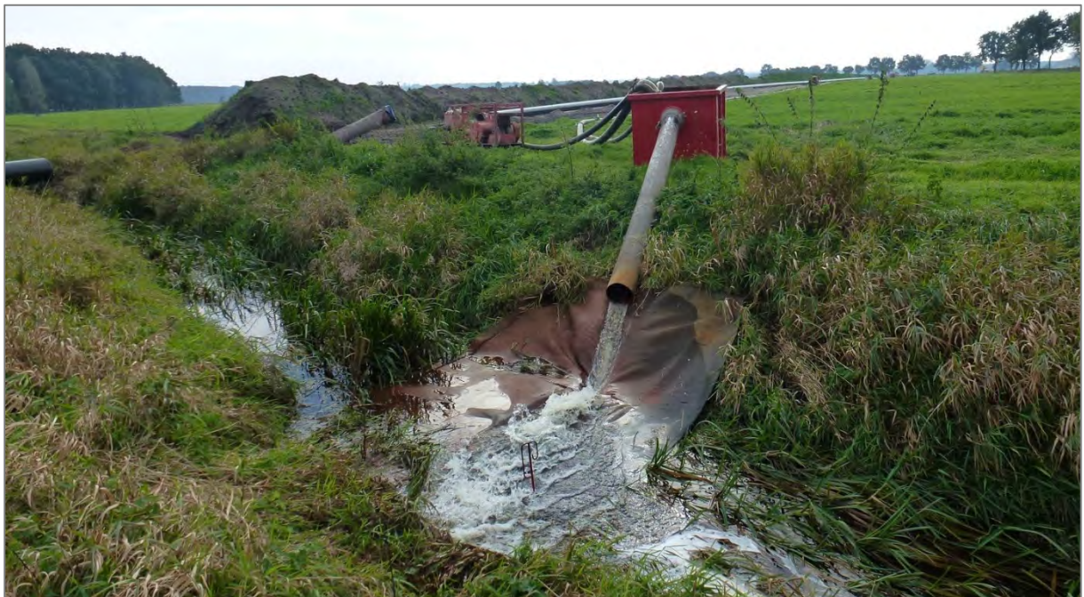
Abbildung 4: Bsp.: Direkte Einleitung des Grundwassers in Oberflächengewässer
