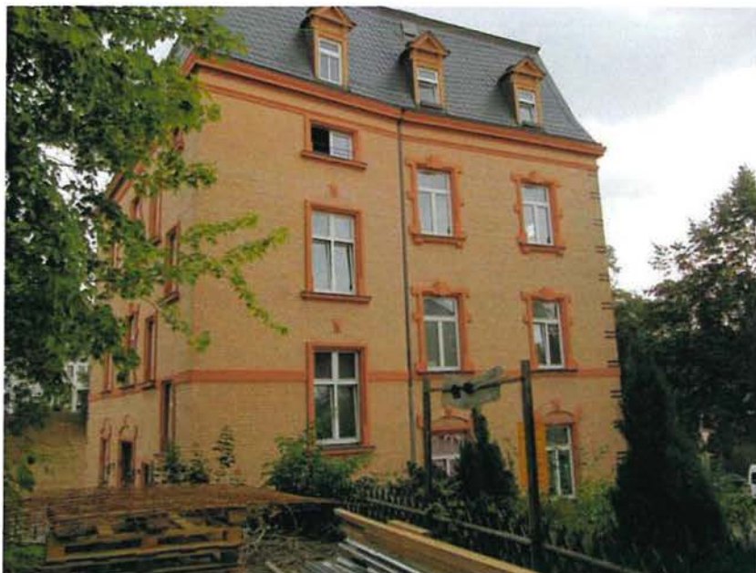
IO 488 Trockentalstraße 50 SW IO 491 Trockentalstraße 50 SW
