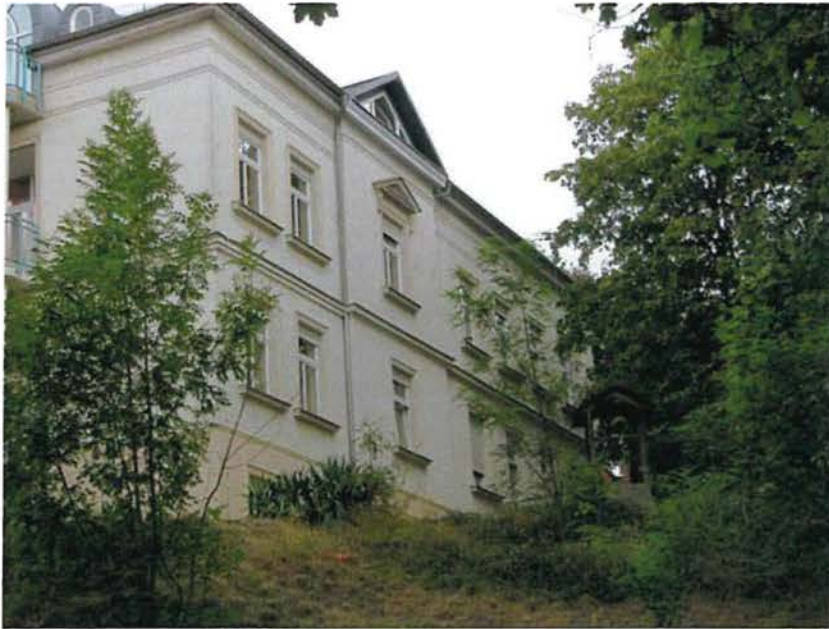
IO 516 Trockentalstraße 61 SO
