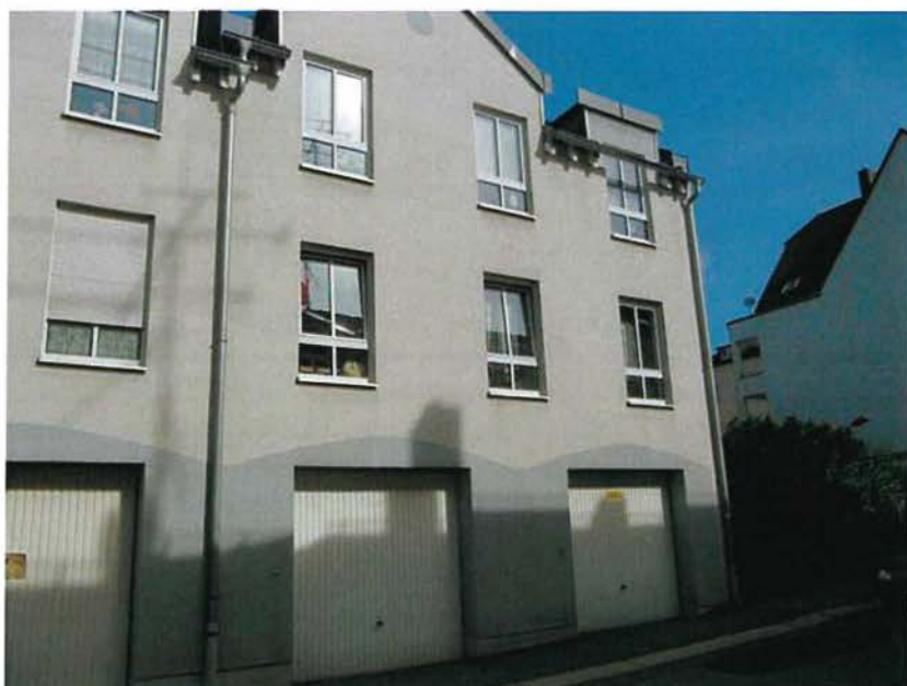
IO 117 Friedrichstraße 24 SO IO 118 Friedrichstraße 24 NW
