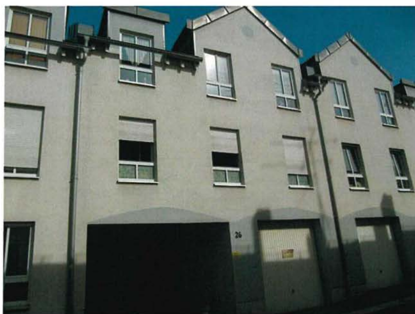
IO 119 Friedrichstraße 26 SO IO 120 Friedrichstraße 26 NW
