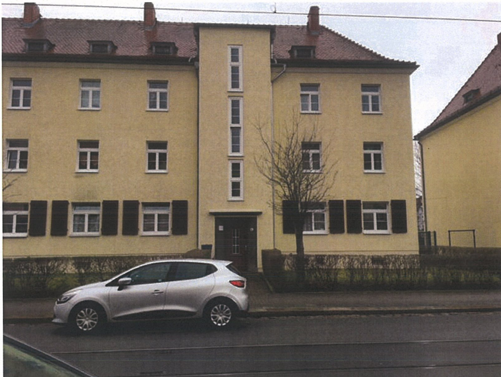
Bild 23 Steinbacher Straße 15, Nord-Ansicht
