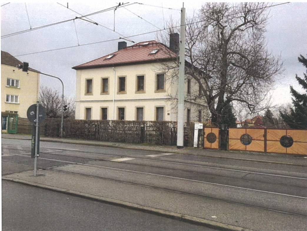
Bild 18 Steinbacher Straße 10, Südost-Ansicht
