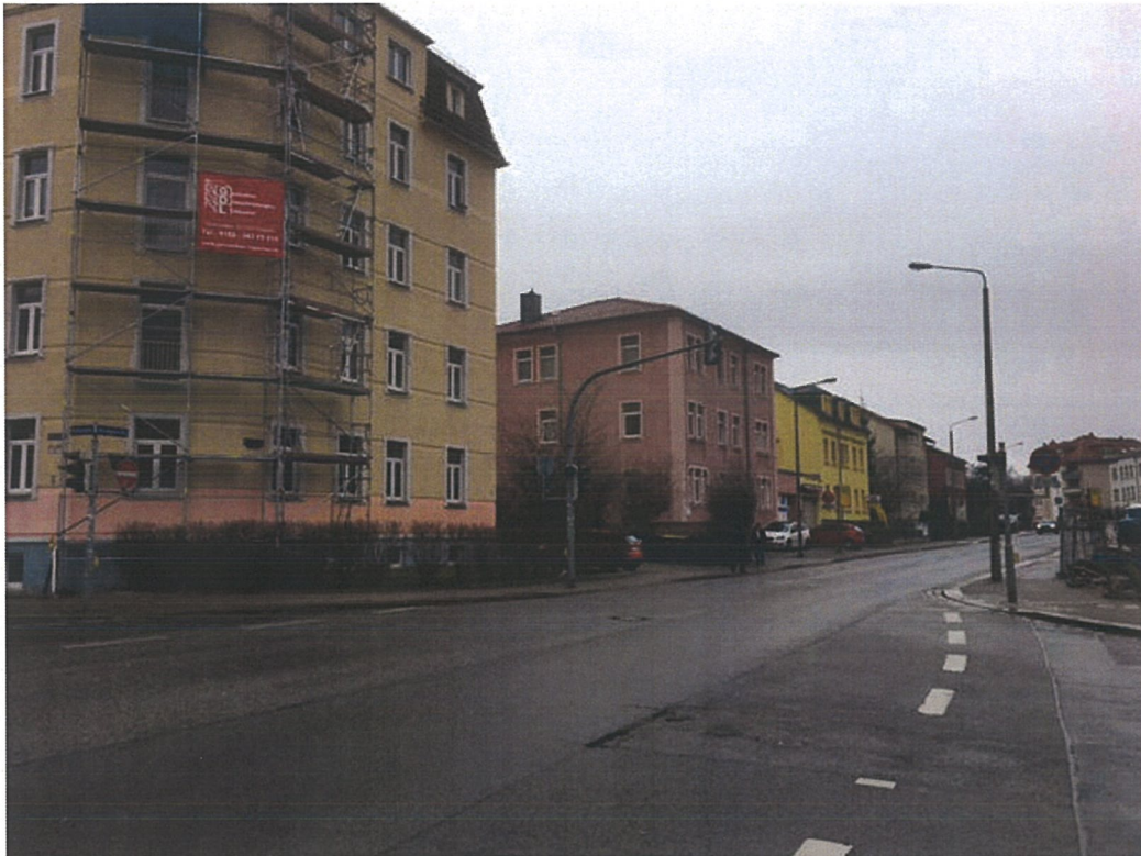
Bild 33 Steinbacher Straße 21, 23, Nordost-Ansicht
