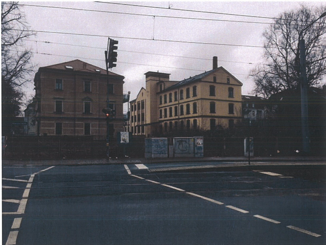
Bild 7 Hölderlinstraße 9, 9a , Nordost-Ansicht
