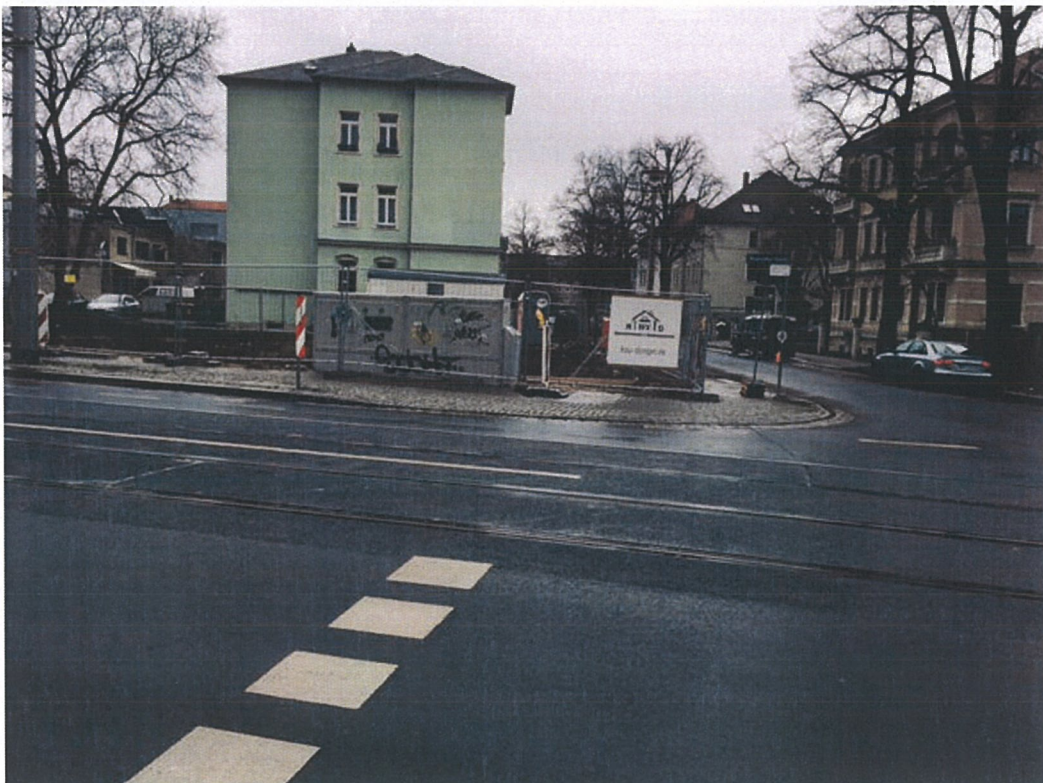
Bild 8 Hölderlinstraße 10, Steinbacher Straße 35 (Baugrube), Nord-Ansicht
