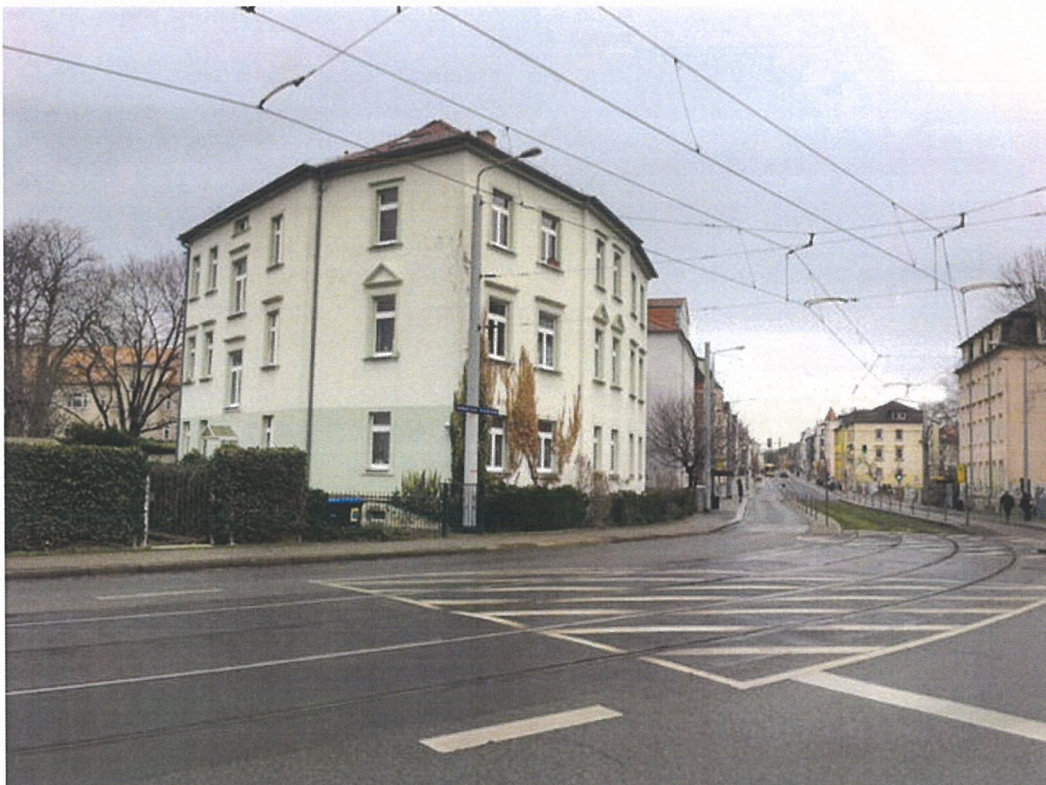
Bild 16 Pennricher Straße 44, Südwest-Ansicht
