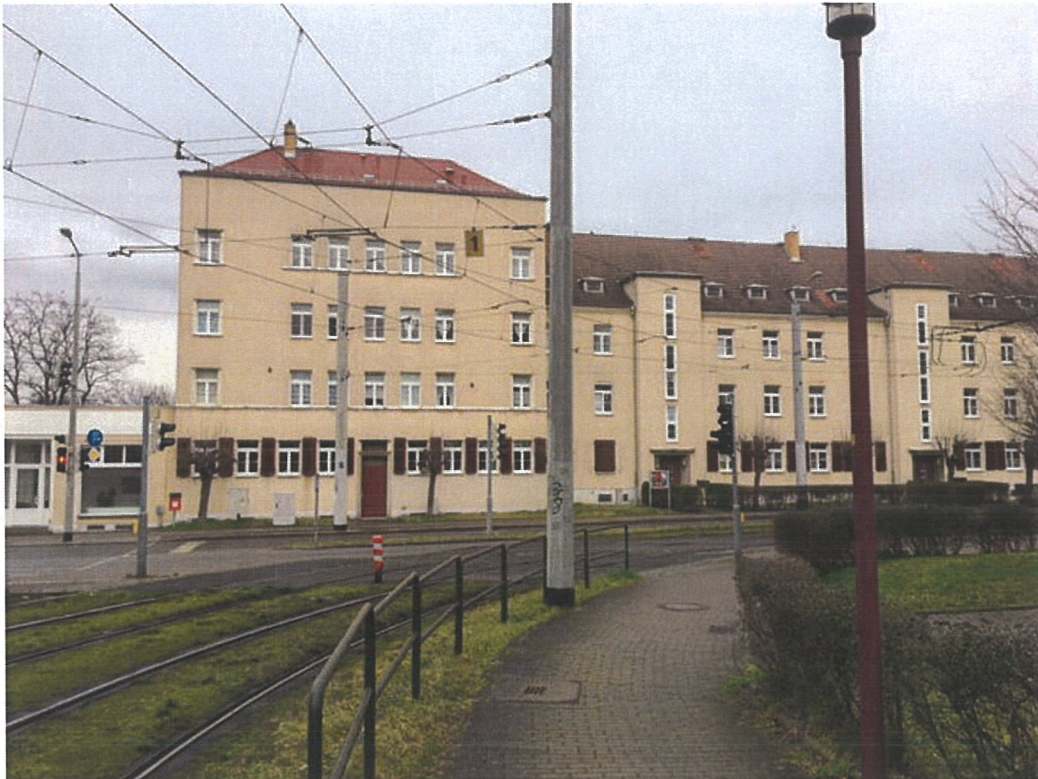
Bild 31 Hebbelstraße 43, Steinbacher Straße 24b, 24, 22b, Süd-Ansicht
