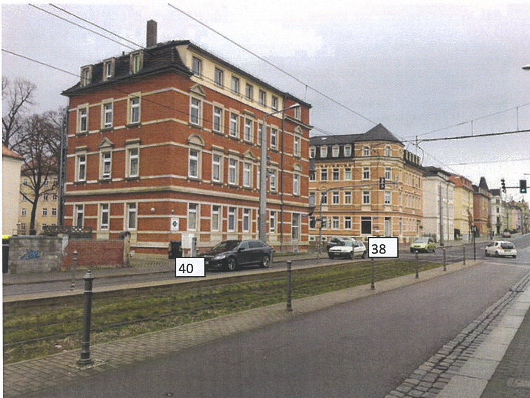
Bild 12 Pennricher Straße 40, 38, Südwest-Ansicht
