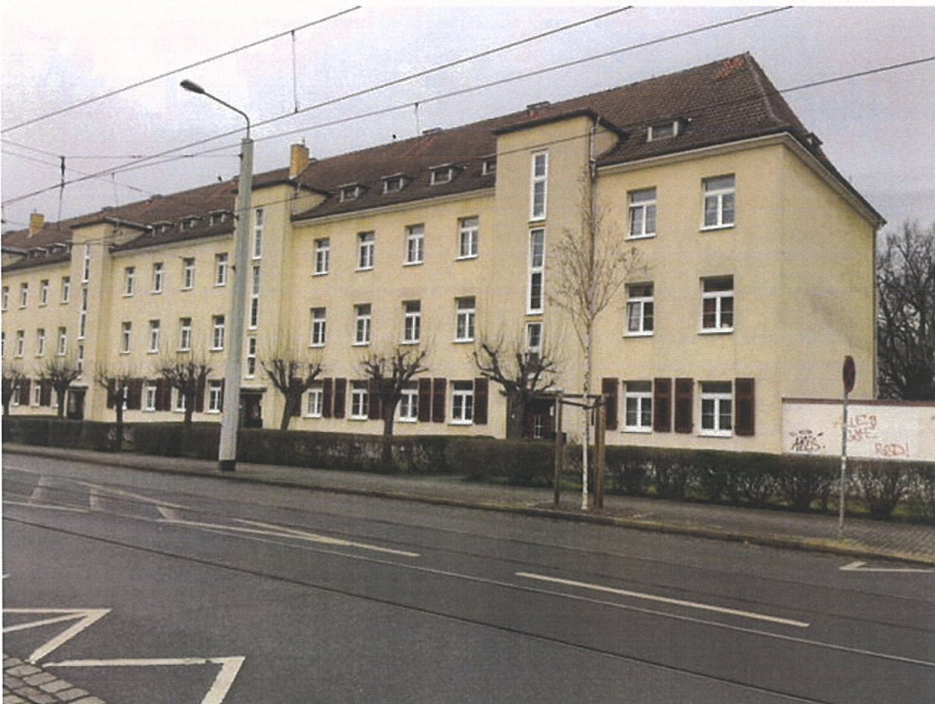
Bild 30 Steinbacher Straße 20, 20b, 22, Südost-Ansicht
