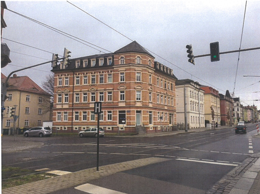
Bild 9 Pennricher Straße 38, West-Ansicht
