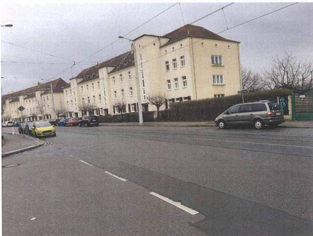
Bild 20 Steinbacher Straße 12, 12b, 14, Südost-Ansicht
