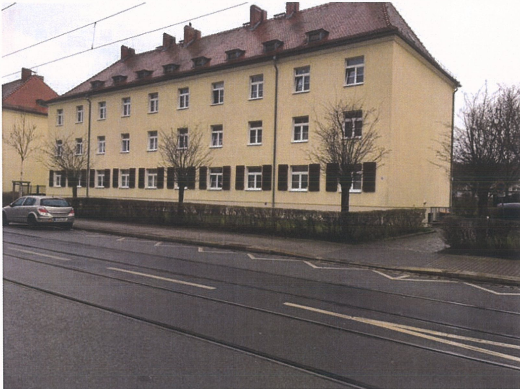
Bild 25 Steinbacher Straße 15b, 17, Nordwest-Ansicht
