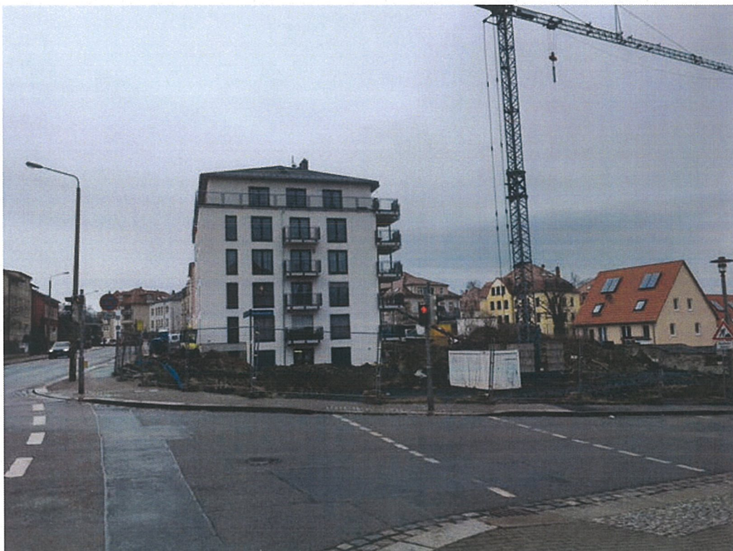
Bild 34 Steinbacher Straße 28, 26 (Baustelle), Südost-Ansicht
