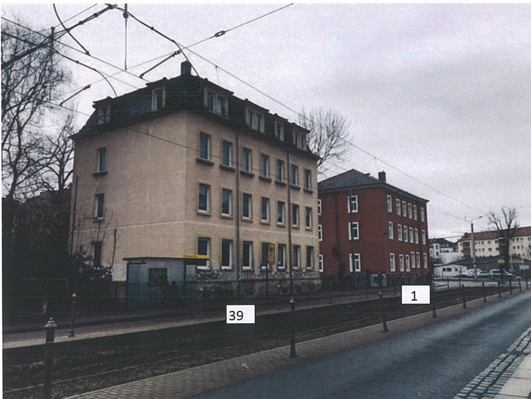
Bild 10 Steinbacher Straße 39, Chamissostraße 1, Nordost-Ansicht
