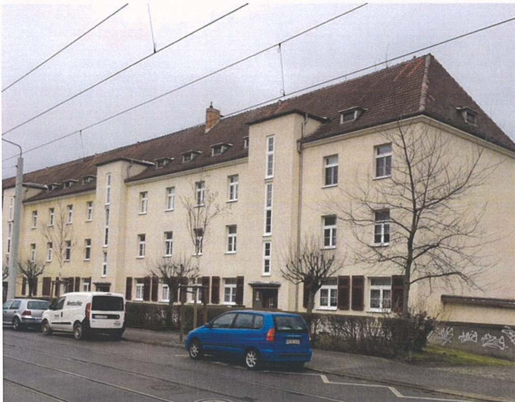
Bild 26 Steinbacher Straße 14b, 16, 16b, Südost-Ansicht
