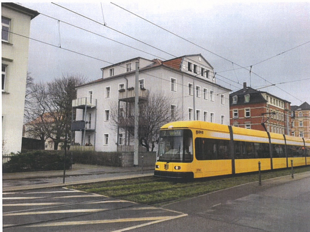
Bild 14 Pennricher Straße 42, Südwest-Ansicht
