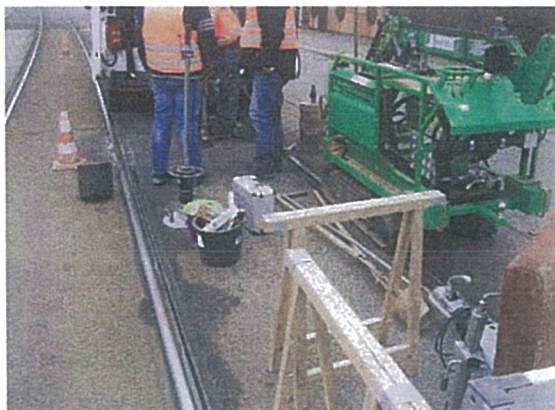
Bild 3: Bohrarbeiten im Gleisbereich - KRB 2
