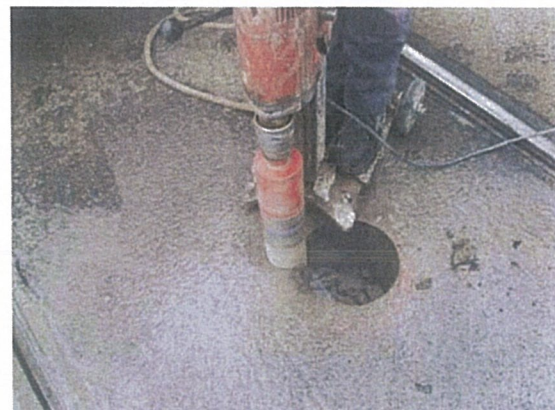
Bild 4: Asphaltkernbohrung KRB 2
