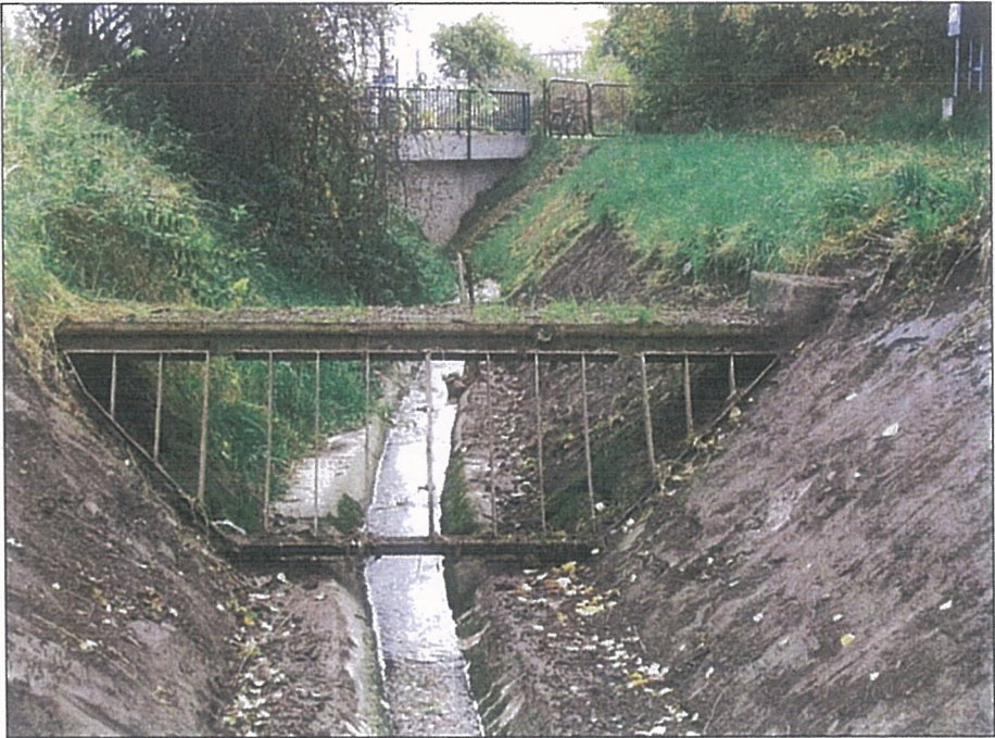
Abb. 18: Treibgutfang TF LE 38 Gorbitzbach westlich Kesselsdorfer/ W.-Hippler-Straße
