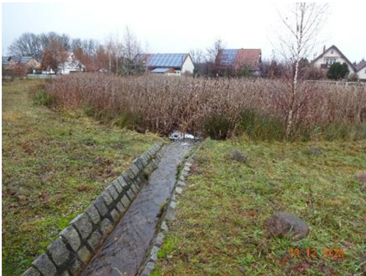
Abbildung 21: Das Ablaufbauwerk des Neuen Dorfteiches in Trebendorf am 13.12.2023.
