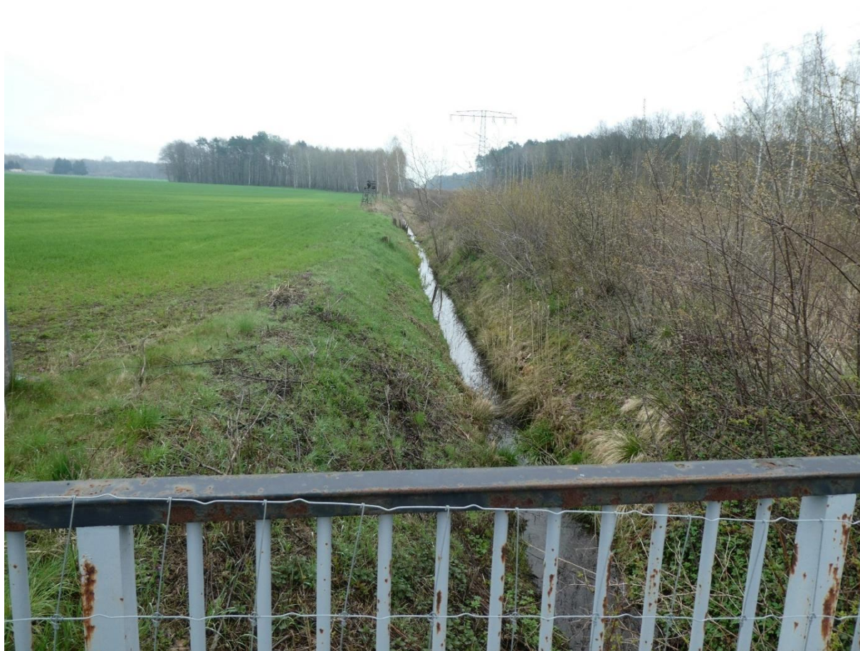
Abbildung 16: Lieskauer Wasser, Blick von Straßenbrücke (Schleifer Allee) Flussaufwärts, 18.04.2023
