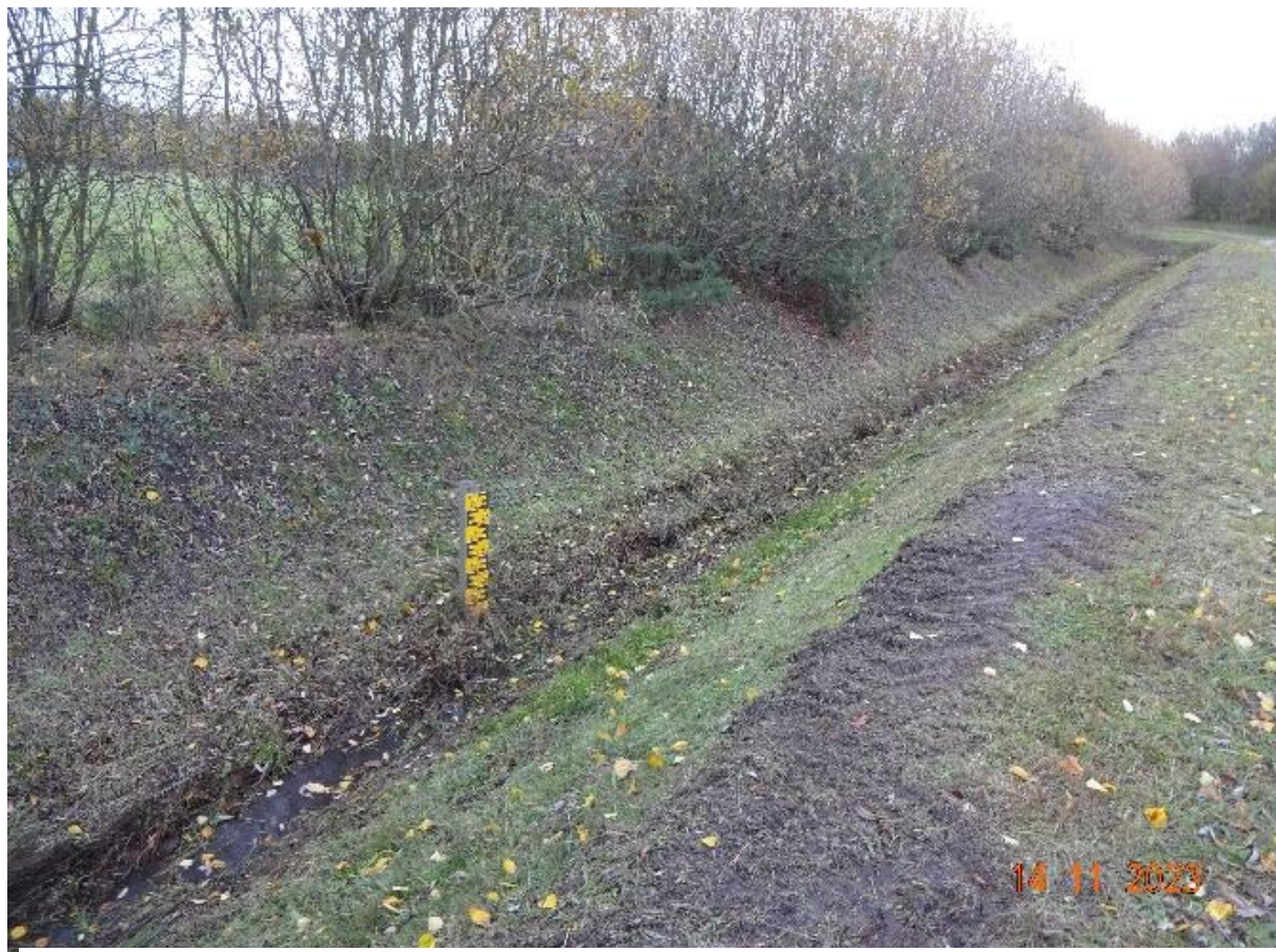
Abbildung 14: Der Kaupegraben nördlich von Trebendorf, mit dem Lattenpegel.
