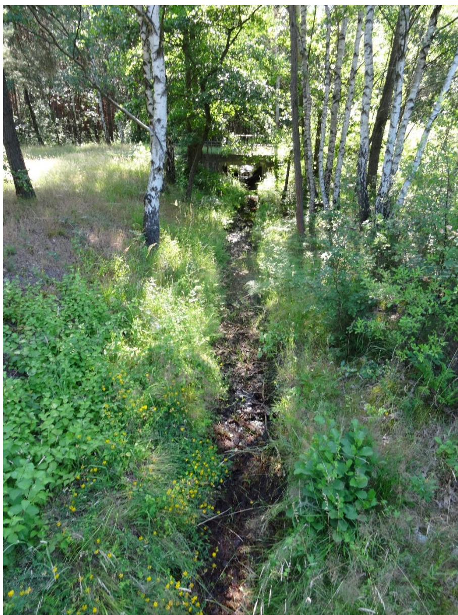
Abbildung 28. Der Regenwasserableiter-Süd kurz vor der Straßenbrücke der Süßmuthlinie in Blickrichtung Südwest, 07.07.2023
