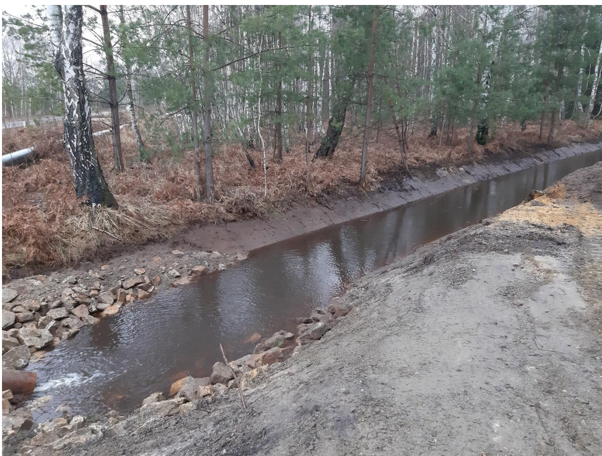
Abbildung 27: Der Nordgraben im Bereich der Einleitung von Zusatzwasser 21.02.2023.
