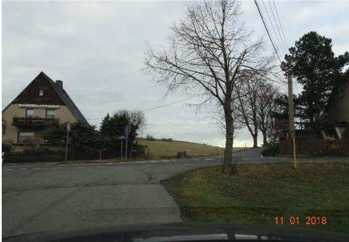
Bild 13 – K6713 Schleppkurve beengt
