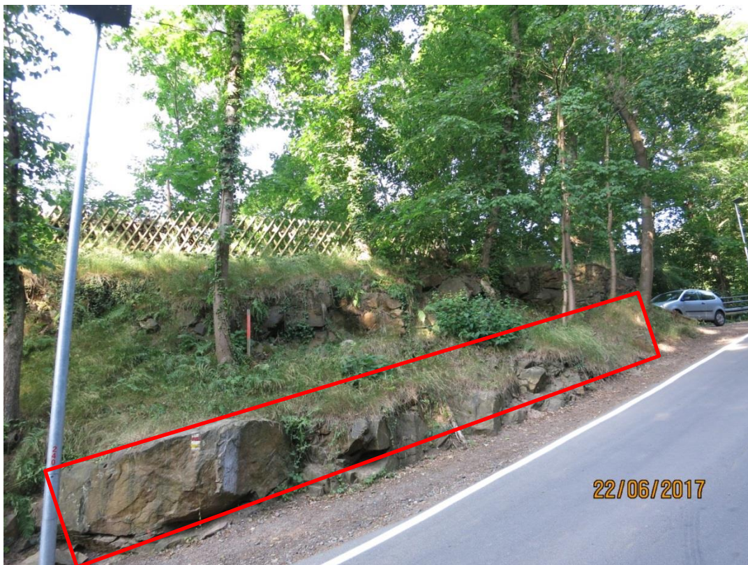
Bild 3: Bereich zwischen Zufahrt Burggarten und Zufahrt Burg mit geplantem Teilabtrag einer Felsstufe zur Anlage eines Gehweges, Abtragsbereich rot eingerahmt
