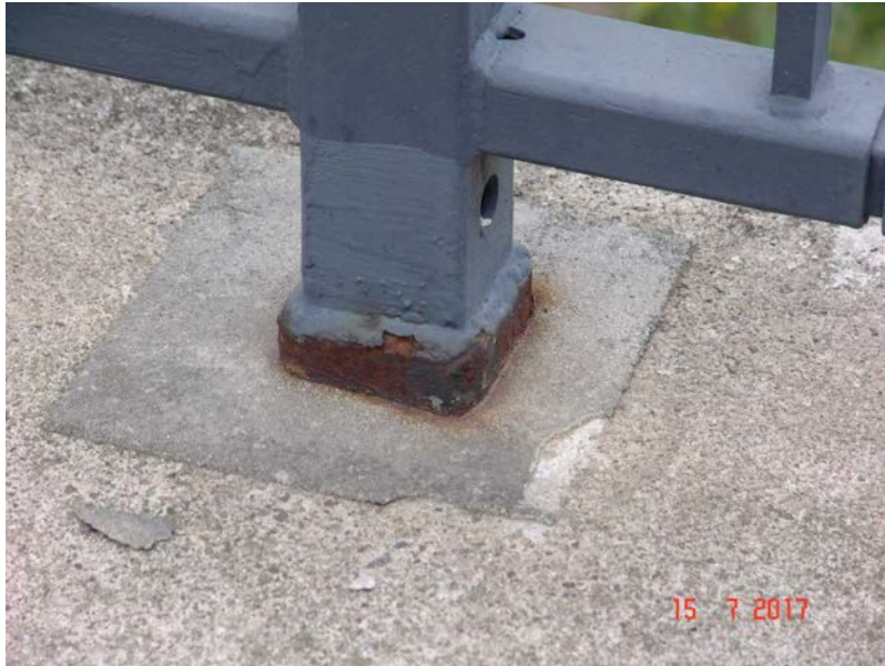
2017H 09 - RECHTES GELÄNDER PFOSTEN 2 - KORRODIERT
