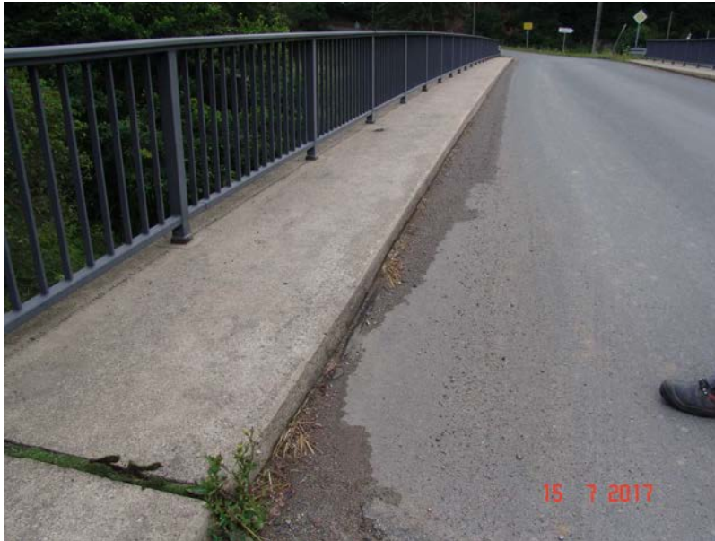
2017H 15 - LINKER FB-RAND - SCHMUTZABLAGERUNGEN
