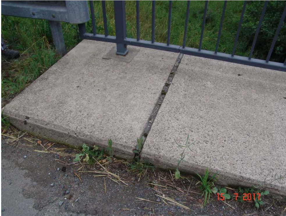
2017H 07 - SONDERFUGE LINKS BWA - BEWACHSEN
