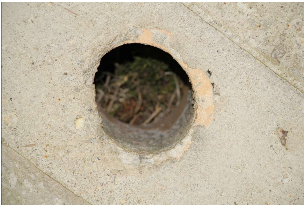
Tonröhre in den Brückenhohlraum (westliche Seite, unterstrom) mit Nistmaterial (22.04.2021) als Beleg für eine Nutzung durch Höhlenbrüter
