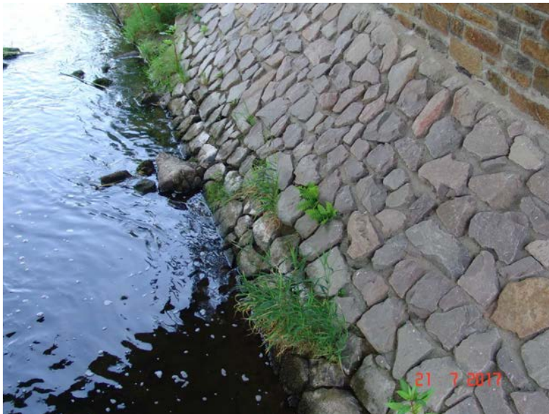
2017H 12 - WL2 UFERBEFESTIGUNG - FUGEN AUSGESPÜLT
