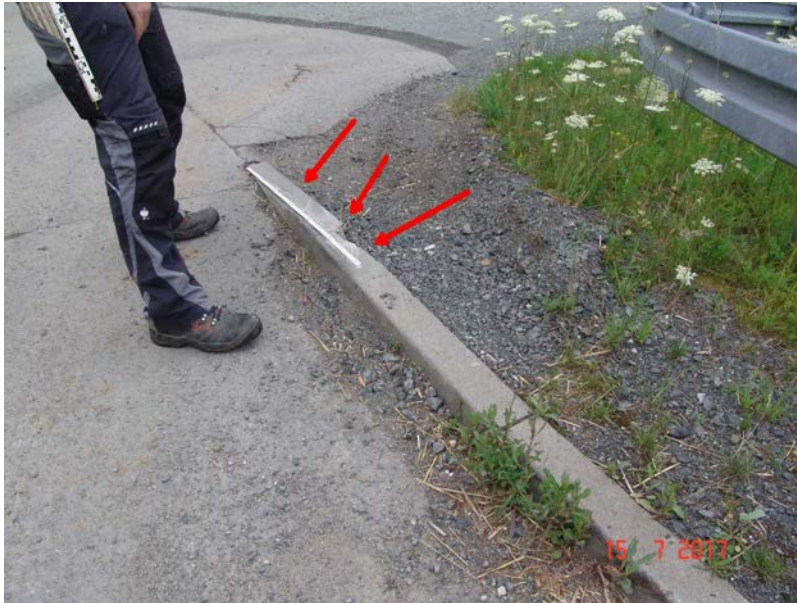
2017H 14 - RECHTER BORD BWE - BESCHÄDIGT
