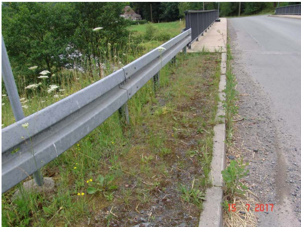
2017H 10 - RECHTER GEHWEG BWE - ABGESACKT UND BEWACHSEN
