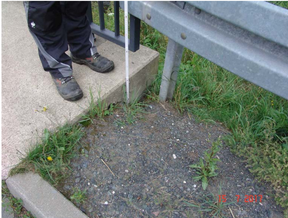
2017H 10 - RECHTER GEHWEG BWE - ABGESACKT UND BEWACHSEN
