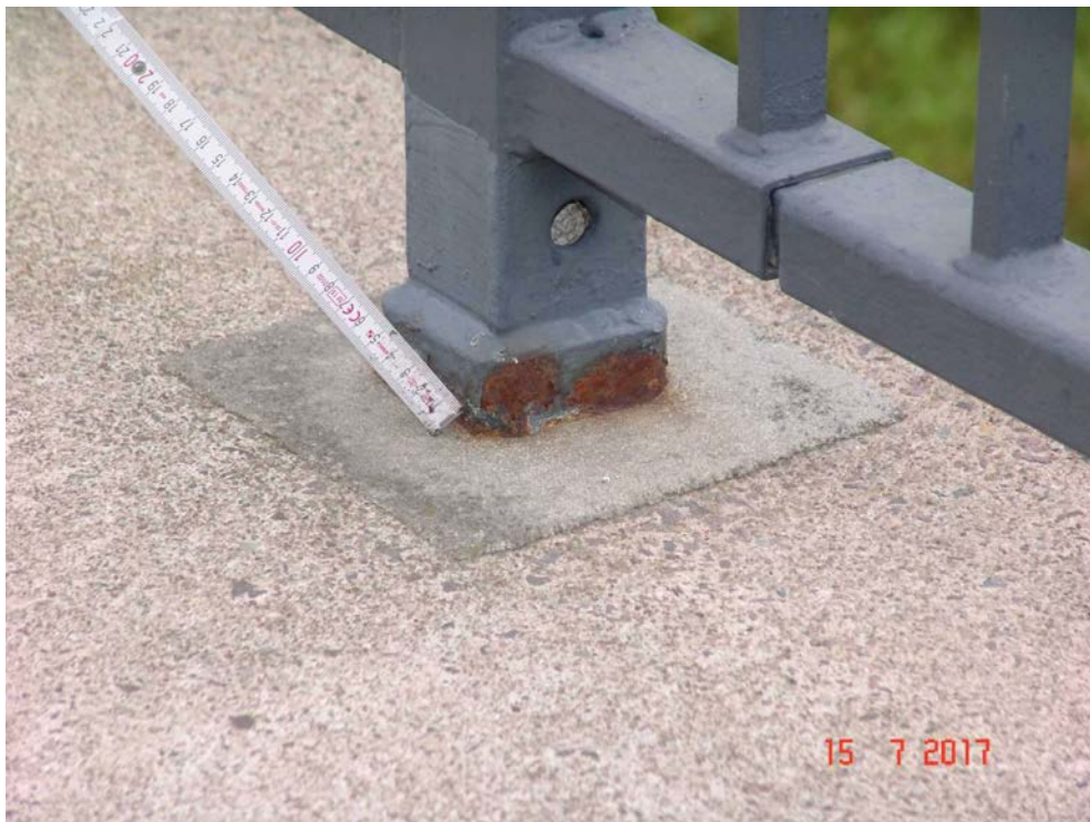
2017H 09 - RECHTES GELÄNDER PFOSTEN 5 - KORRODIERT
