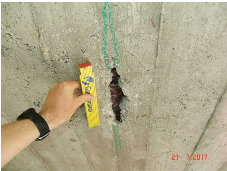
2017H 31 - TW-U 140 CM VON LINKS - SPANNGLIED FREILIEGEND
