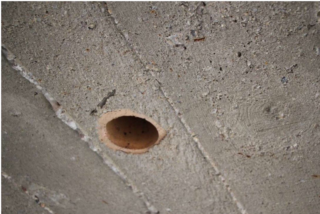
Auf westlicher Seite befinden sich 2 Öffnungen in den Brückenhohlraum (Tonröhren mit Innendurchmesser 6 cm) – 2020 ohne Beleg für Quartiernutzung
