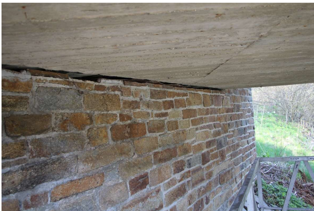
Spalte zwischen Brückenkörper und verblendetem Wiederlager – westliche Brückenseite (Unterseite, sehr schmaler Spalt, ohne Hinweis auf Quartiernutzung, Nistplatz) 17.04.2020
