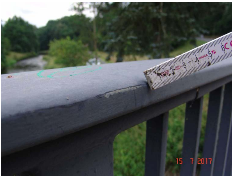
2017H 17 - LINKES GELÄNDER PFOSTEN 18 - BESCHICHTUNG BESCHÄDIGT
