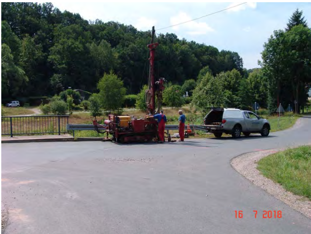
Bohrgerät am Aufschlussansatzpunkt der BK 2/18
