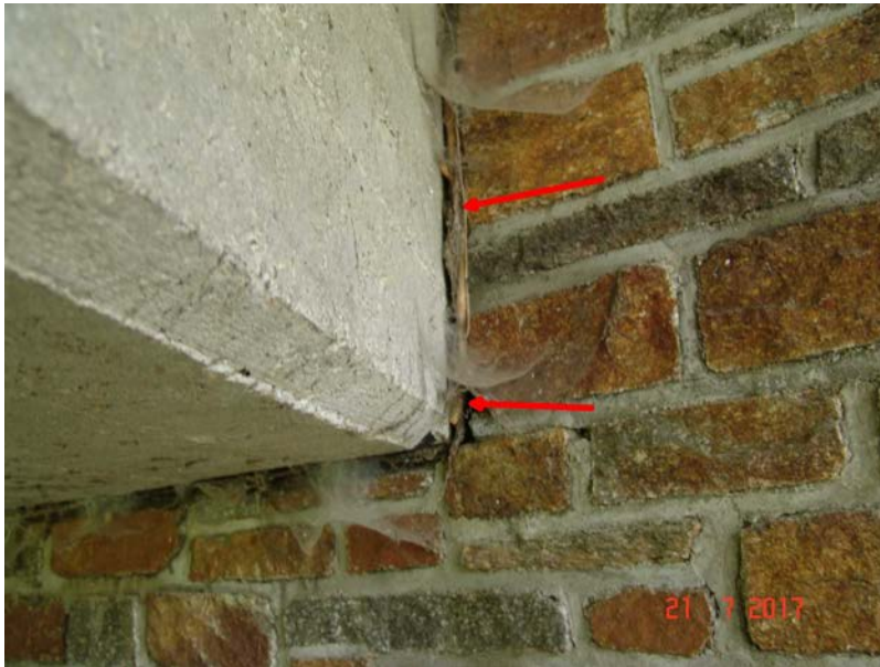
2017H 23 - WL2 RECHTS - FUGE ÜBERBAU-WL NICHT ENTKOPPELT
