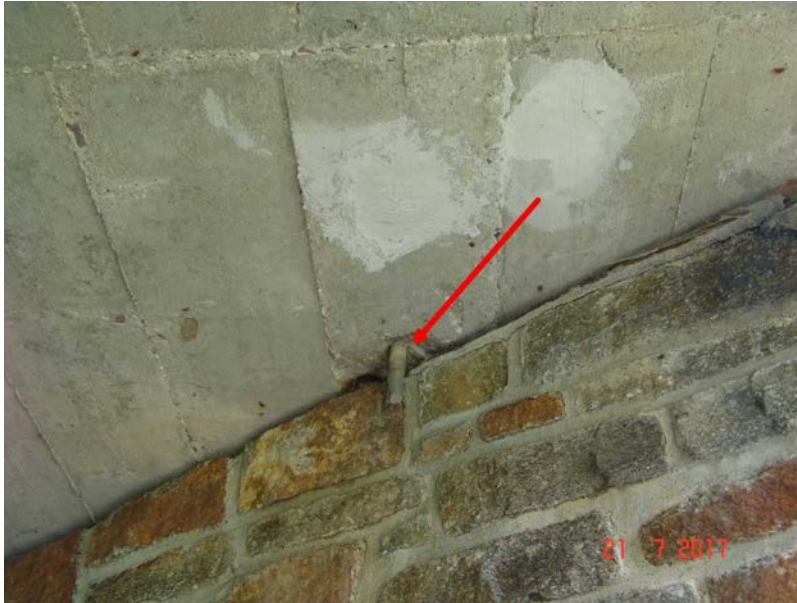
2017H 04 - RECHTER KRAGARM WL2 - KAPPENVERANKERUNG MUTTER FEHLT
