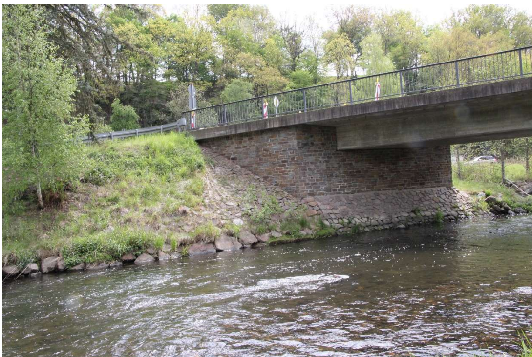
Blick von unterstrom auf das östliche Brückenwiderlager, die Steinböschungen und die massiv befestigte Uferlinie (13.05.2020)
