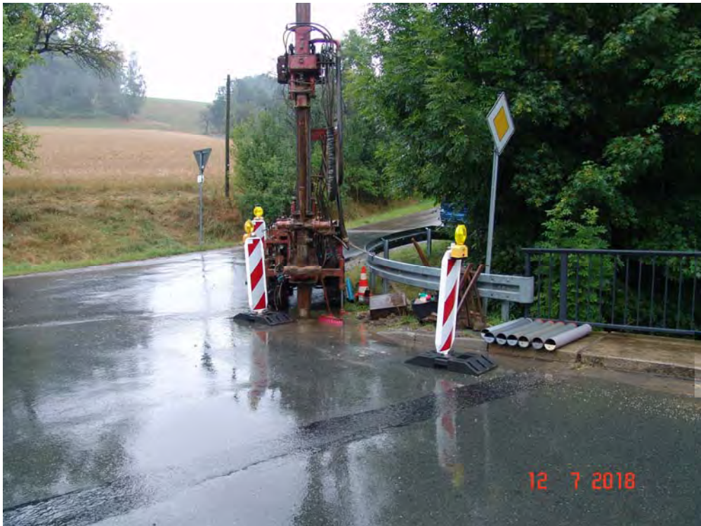
Bohrgerät am Aufschlussansatzpunkt der BK 1/18
