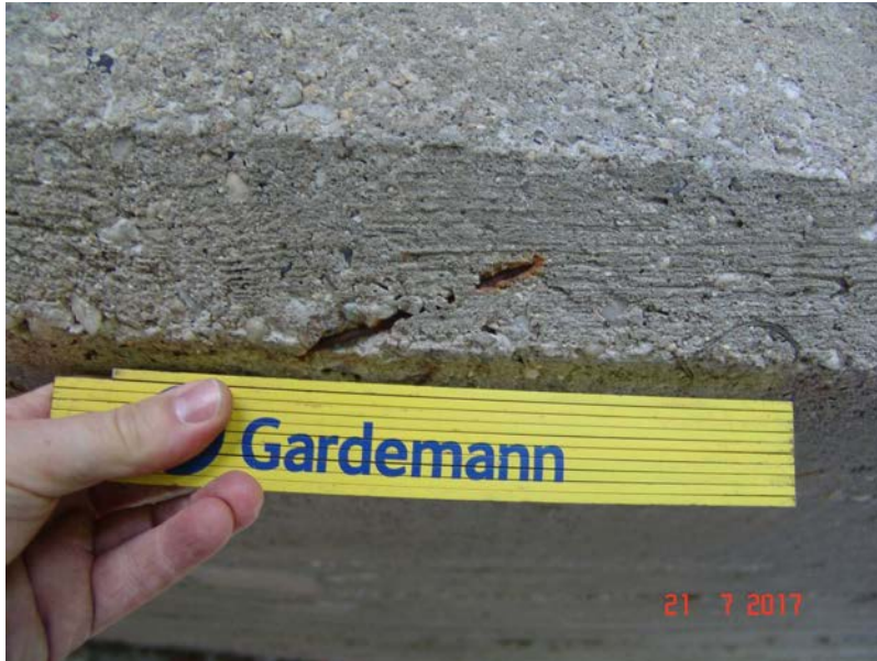
2017H 22 - TW-U LINKER RAND BWE - NAGEL EINBETONIERT
