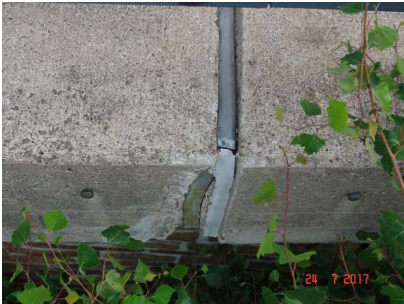
2017H 05 - RECHTES GESIMS WL1 - BETON BRÜCHIG - FUGENBAND VERDRÜCKT
