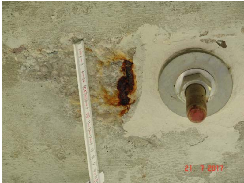
2017H 24 - RECHTER KRAGARM ANKER 5 VOR BWE - BEWEHRUNG DURCHROSTET
