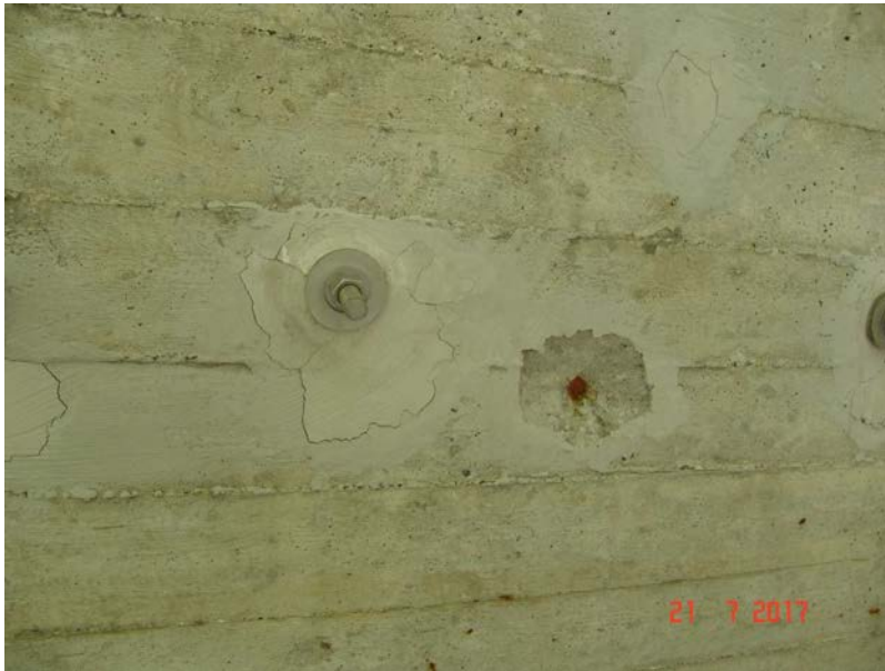
2017H 02 - KRAGARMUNTERSEITE LINKS 7M VOM BWA - BETONSANIERUNG NICHT FACHGERECHT
