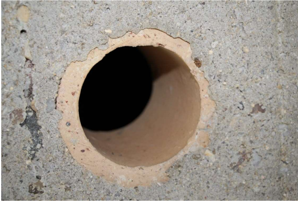
Auf östlicher Seite befinden sich ebenfalls 2 Öffnungen in den Brückenhohlraum (Tonröhren mit Innendurchmesser 6 cm, ohne Hinweis auf Quartiernutzung)
