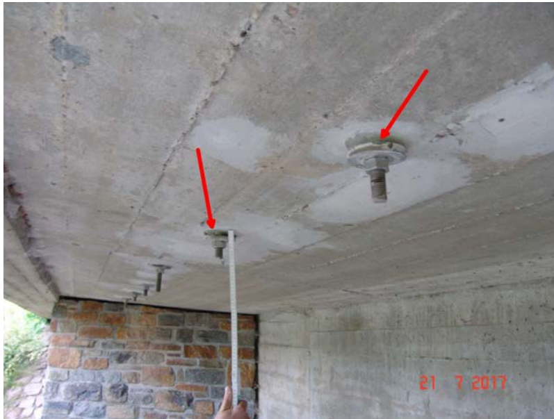
2017H 20 - LINKER KRAGARM BWE - KAPPENVERANKERUNG LOCKER
