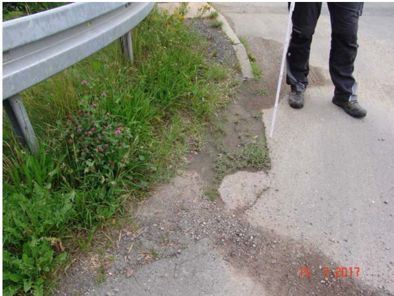
2017H 13 - LINKE BÖSCHUNG BWA - WASSERSTAU
