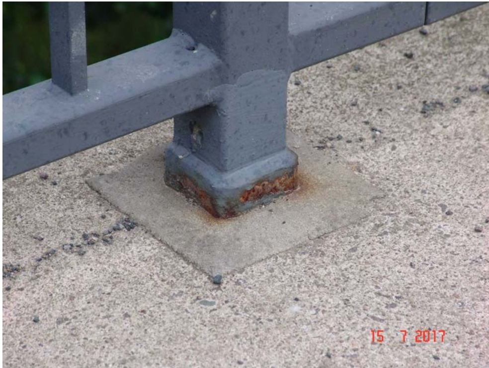
2017H 09 - RECHTES GELÄNDER PFOSTEN 5 - KORRODIERT
