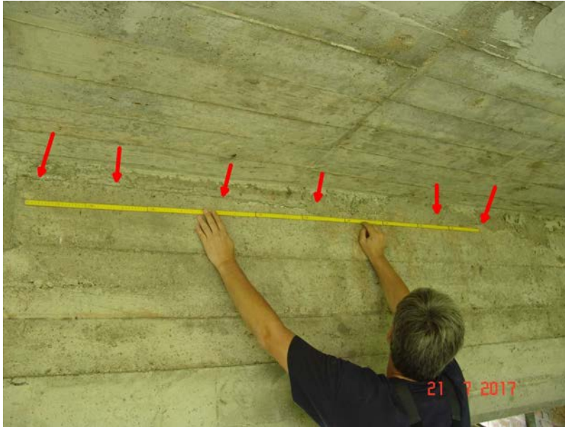
2017H 19 - LINKER KRAGARM 4M VOM BWA - BETONIERANSATZ GERISSEN
