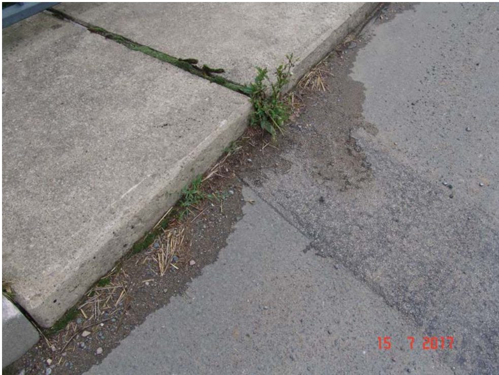
2017H 07 - SONDERFUGE LINKS BWA - BEWACHSEN
