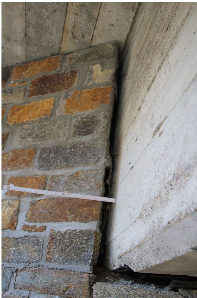
Spalte zwischen Brückenkörper und verblendetem Wiederlager – westliche Brückenseite (ca. 4 cm breit, ohne Hinweis auf Quartiernutzung, Nistplatz) 17.04.2020
