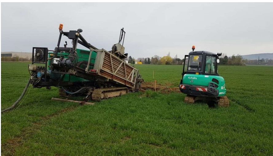
Abbildung 8: Beispiel für die Herstellung einer Pilotbohrung mittels HDD-Verfahren
