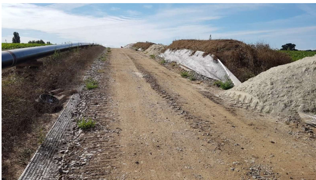
Abbildung 6: Beispiel einer geschotterten Baustraße über Trennvlies + Geogitter
