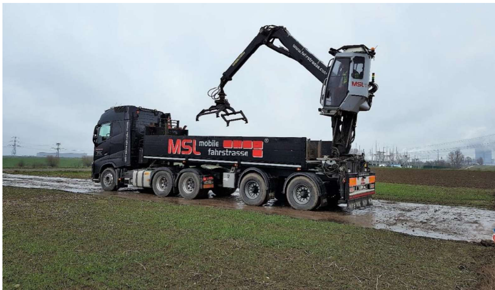
Abbildung 5: Beispiel der Verlegung einer mobilen Baustraße mittels Kran-Lkw im Vor-Kopf-Verfahren
