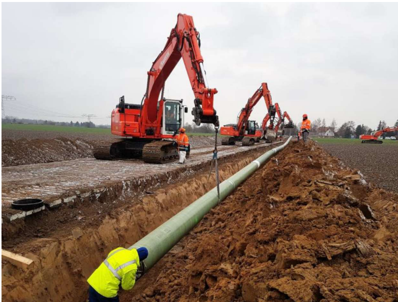
Abbildung 7: Darstellung der Verlegung einer vormontierten Teilstücke einer Gasleitung (hier DN 500) in offener Bauweise,
