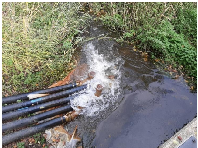
Abbildung 5: Einleitung von Wasser aus der Druckwasserprüfung und den Wasserhaltungsmaßnahmen über nach oben gerichtete Rohre (Foto: PLE)
