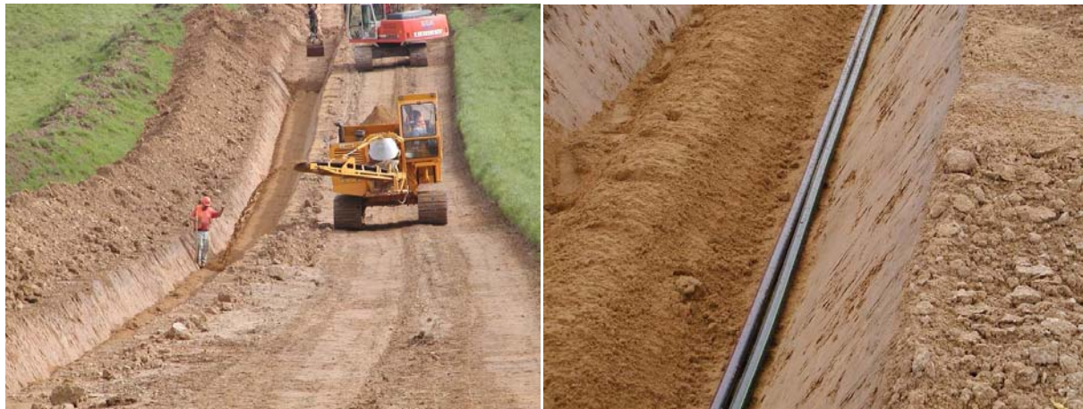
Abbildung 4.4-8: Verfüllen des Rohrgrabens (li) und Verlegung der Kabelanlage (re)
