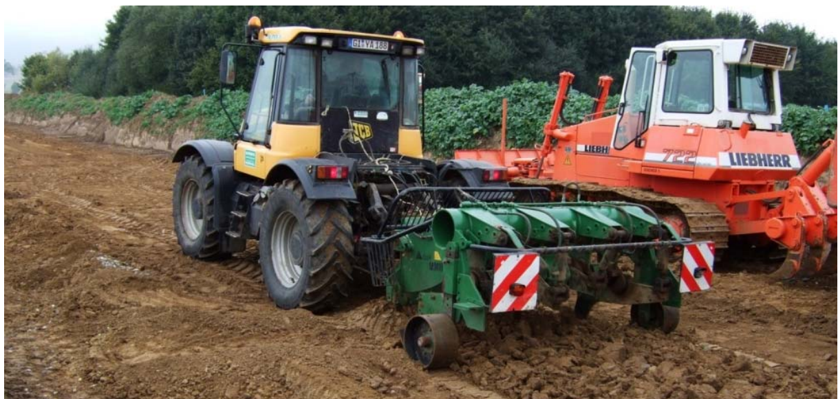
Abbildung 4.4-10: Lockerung des Unterbodens
