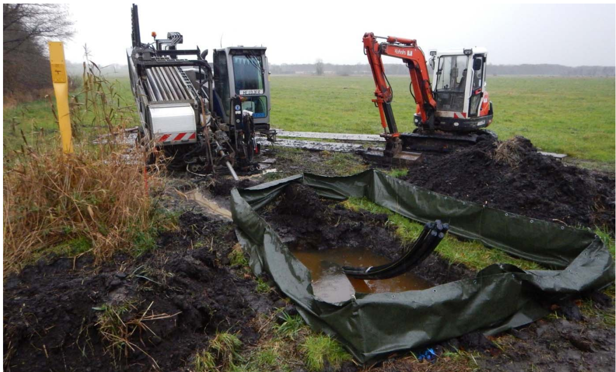
Abbildung 4.10-5: HDD-Rig bei der Kabelrohrverlegung
