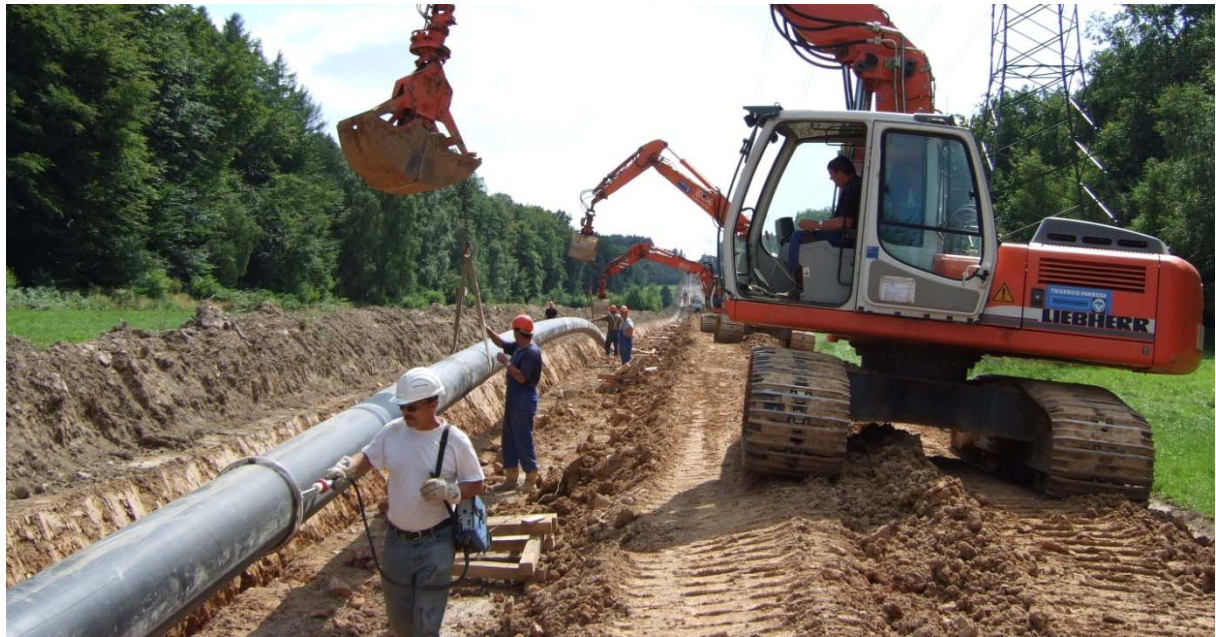
Abbildung 4.4-7: Absenken des Rohrstranges und Isotest
