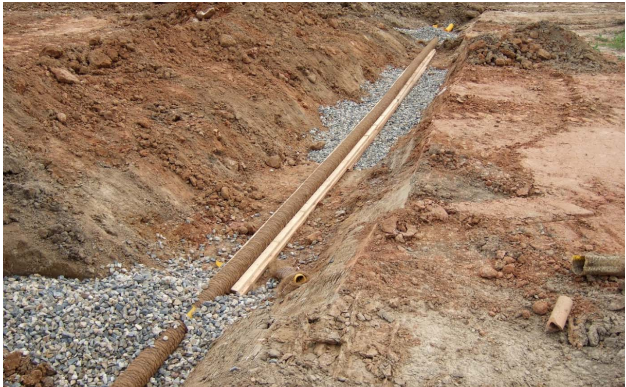
Abbildung 4.4-9: Wiederherstellung einer Dränanlage
