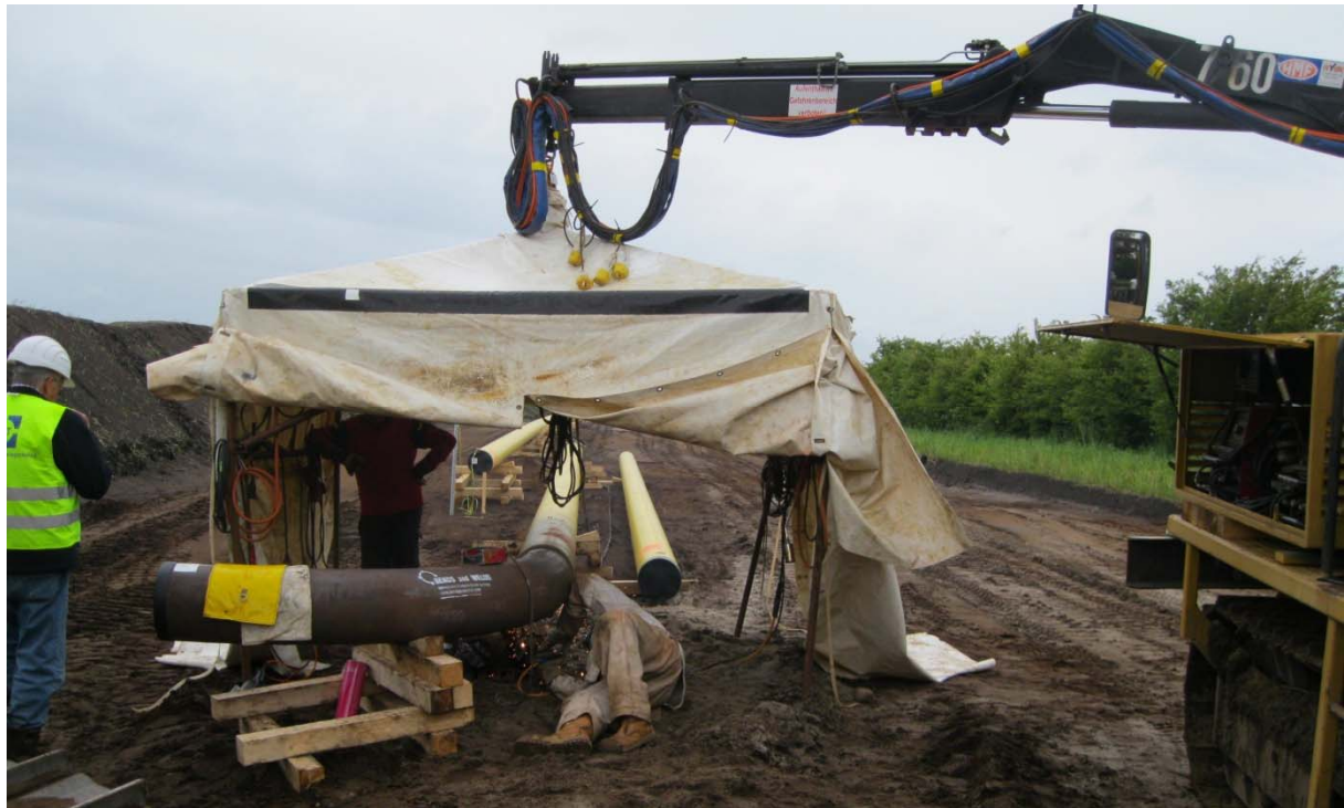
Abbildung 4.4-5: Verschweißen der Rohre
