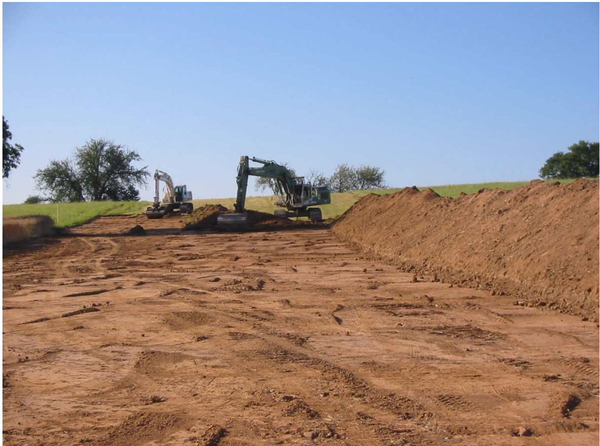
Abbildung 4.4-2: Mutterbodenabtrag
