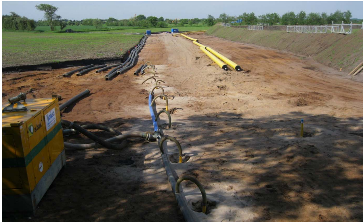
Abbildung 4.4-3: Wasserhaltung mit Spülfiltern
