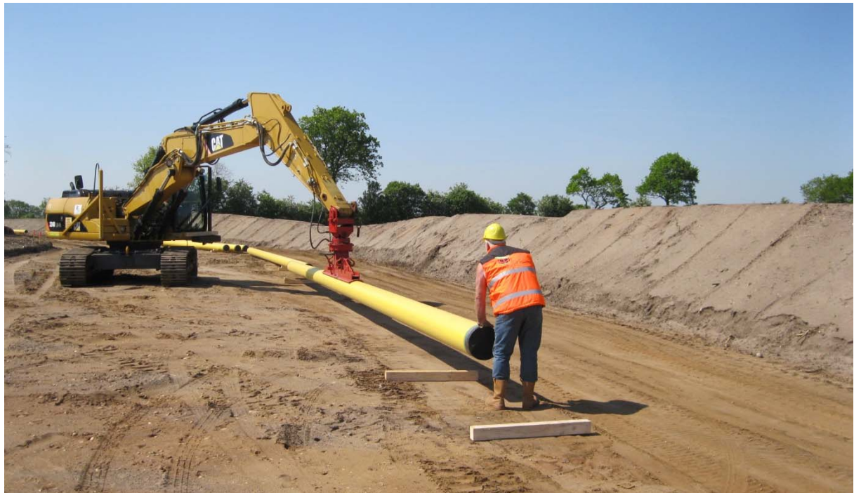
Abbildung 4.4-4: Rohrausfuhr
