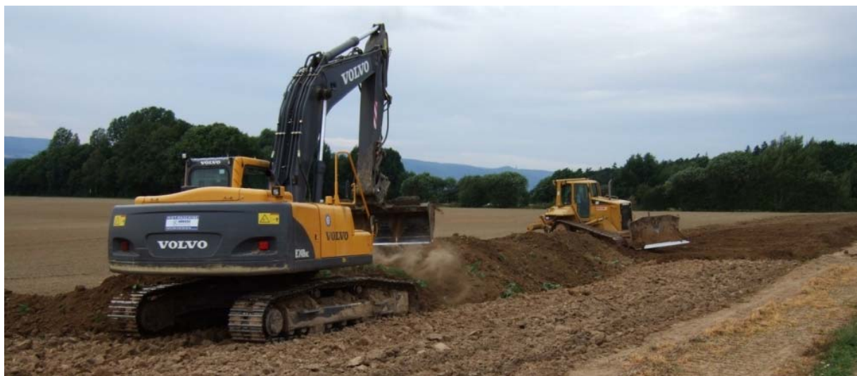
Abbildung 4.4-11: Wiederauftrag des Oberbodens
