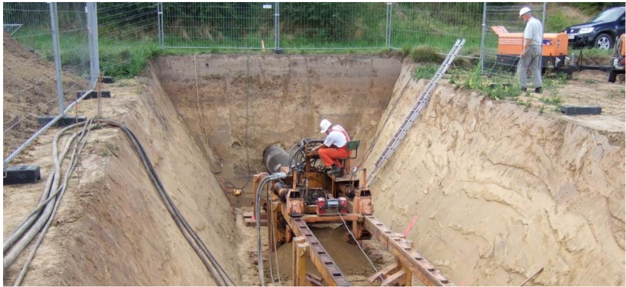
Abbildung 4.9-1: Horizontal-Pressbohrverfahren (Startgrube)
