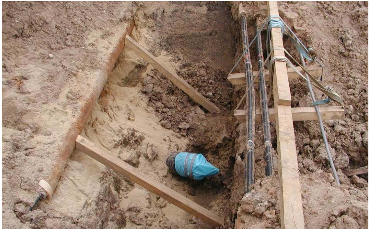
Abbildung 4.5-1: Sicherung von Fremdleitungen (Kabel)
