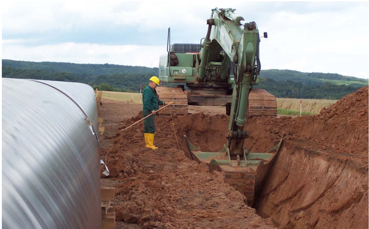
Abbildung 4.4-6: Herstellung des Rohrgrabens
