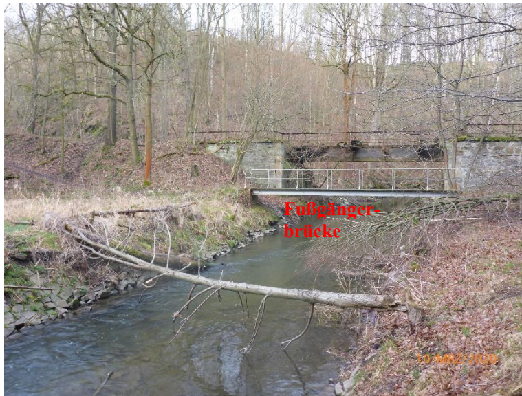
Foto 41: Rückzubauende Fußgängerbrücke über die Kleine Striegis
