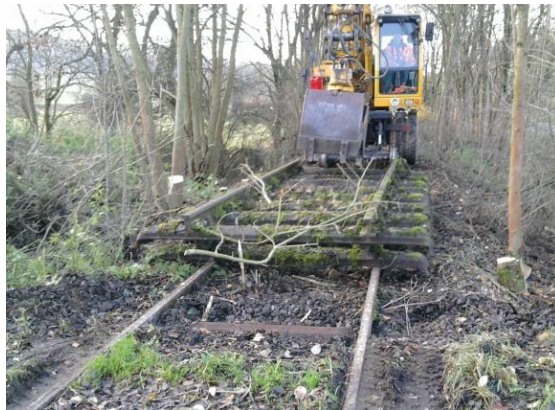
Foto 24: Entfernung von Gleisen und Schwellen (Foto: http://forum.bauforum24.biz/forum/index.php?showtopic=44442 )
