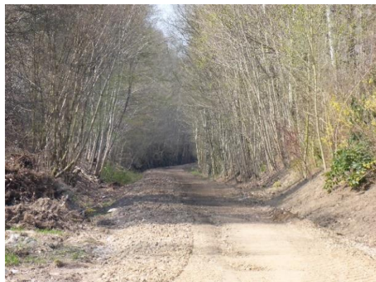
Foto 18: Erhalt der Gehölze durch „Vor-Kopf-Bauweise“ – Sicherstellung des vorhandenen Kronenschlusses
