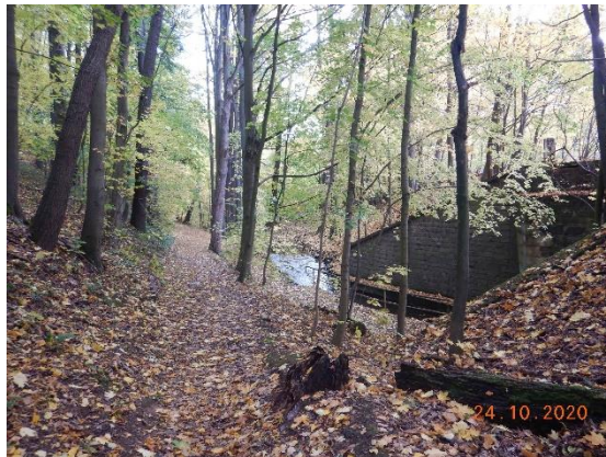
Foto 7: Striegistalweg im Bereich vom BW 01
