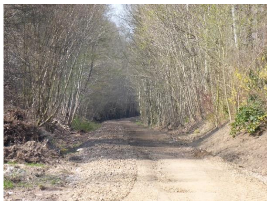
Foto 23: Erhalt der Gehölze durch „Vor-Kopf-Bauweise“ – Sicherstellung des vorhandenen Kronenschlusses
