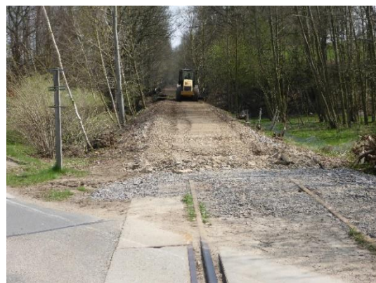
Foto 23: Erhalt der Gehölze durch „Vor-Kopf-Bauweise“ – Sicherstellung des vorhandenen Kronenschlusses
