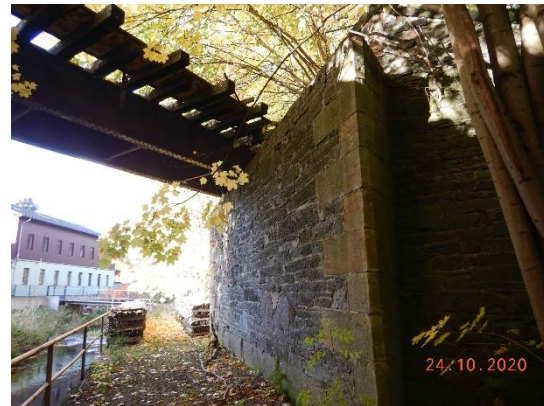
Foto 8: BW 01 mit Blick zur Wohnbebauung Striegisweg 3
