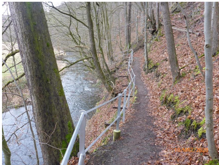
Foto 37: Absturzsicherung im Hangbereich oberhalb der Kleinen Striegis
