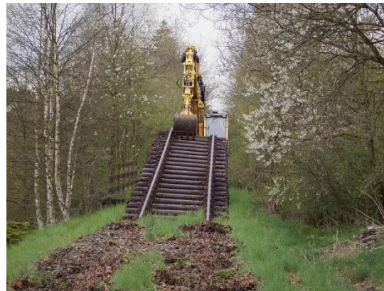
Foto 25: Entfernung von Gleisen und Schwellen (Foto: KERPEN 2015)
