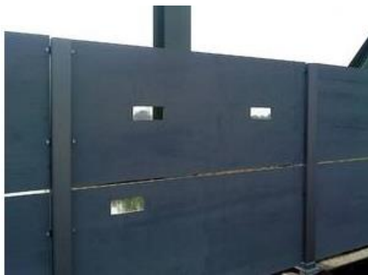
Foto 21: Beispiel einer 2,25 m hohen Sichtschutzwand am Radweg auf dem Brückenbauwerk über das FFH-Gebiet „Lippeaue“ mit Sehschlitzen in verschiedenen Höhen (Stadt Ahlen 2010)
