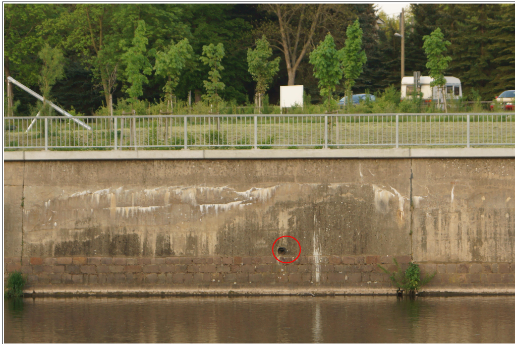
Bild 5: Entwässerungsrrohr in der Ufermauer an den Uferterrassen mit Nistmaterial (rot umkreist)
