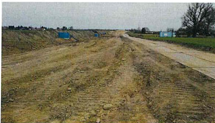
Abbildung 8: Vakuumentwässerung einer Leitungstrasse in einem Feuchtgebiet
