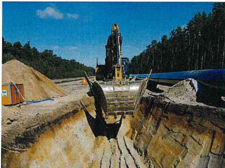
Abbildung 11: Aushub eines Rohrgrabens mittels Trapezlöffel
