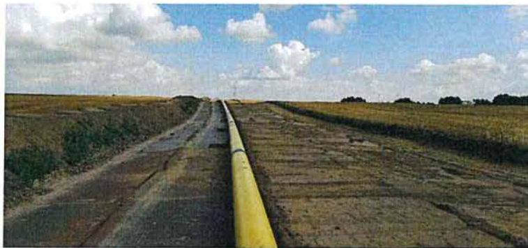
Abbildung 10: Vorgestreckter und verschweißter Rohrstrang
