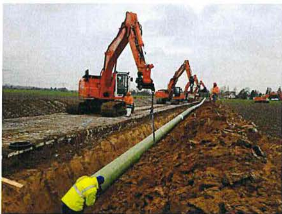
Abbildung 12: Absenken Rohrstrang
