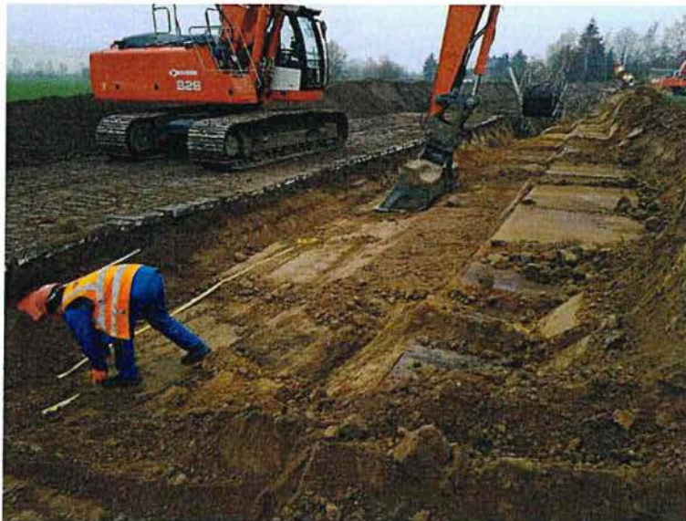
Abbildung 15: Rückverfüllung Rohrgraben und Verlegung Warnband
