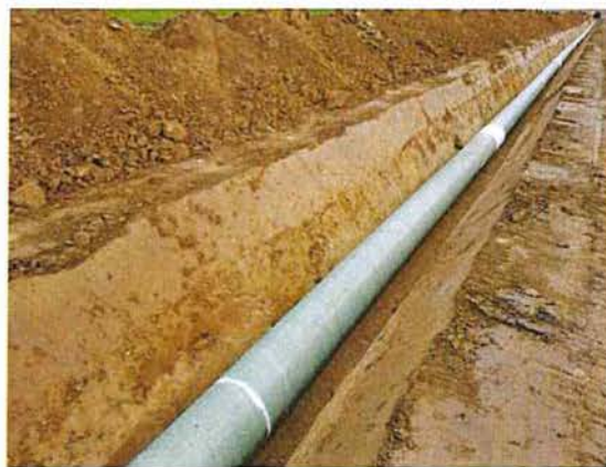
Abbildung 13: Rohrstrang auf Bettung
