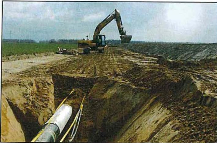
Abbildung 42: Restverfüllung des Rohrgrabens
