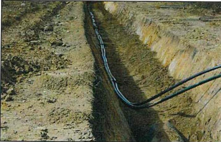
Abbildung 41: Verlegung Kabelleerrohre in offener Bauweise
