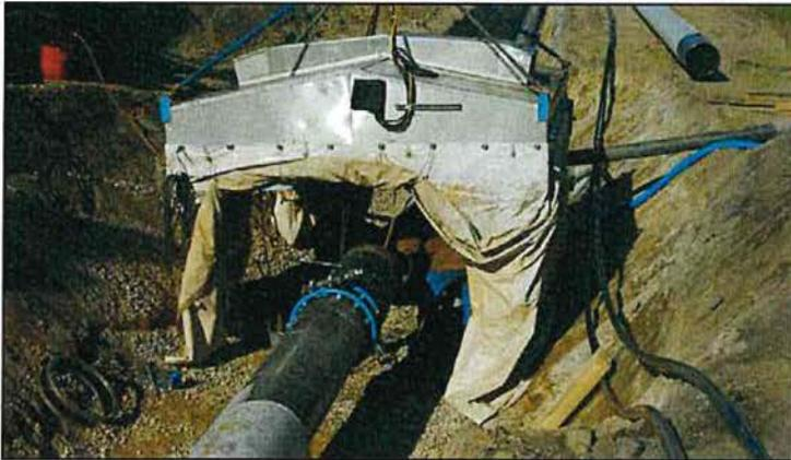
Abbildung 39: Verschweißen zweier Rohrstränge
