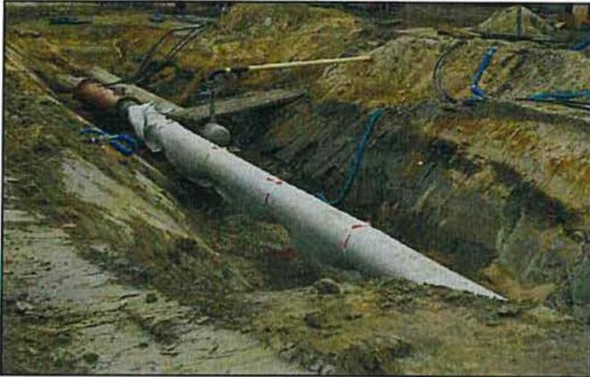
Abbildung 43: Wasserdruckprüfung
