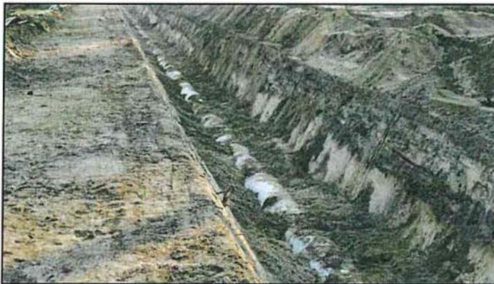
Abbildung 40: Teilverfüllung des Rohrgrabens
