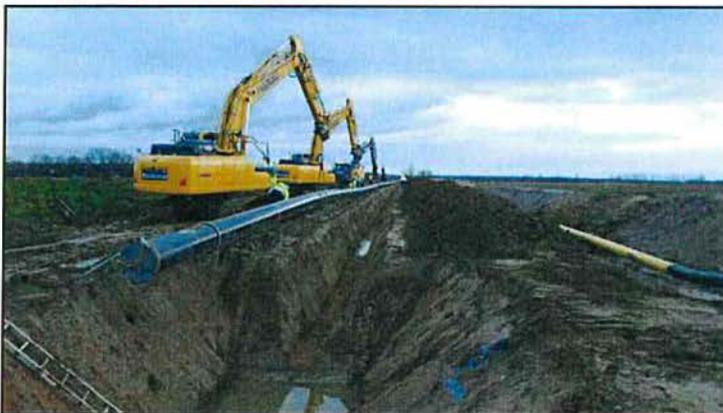
Abbildung 38: Absenken des Rohrstranges
