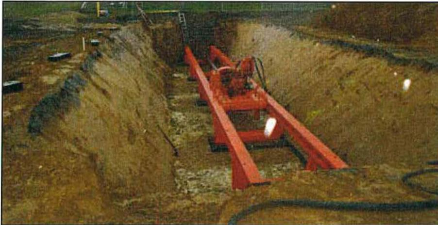
Abbildung 36: geschlossene Querung mittels Pilotrohrvortrieb
