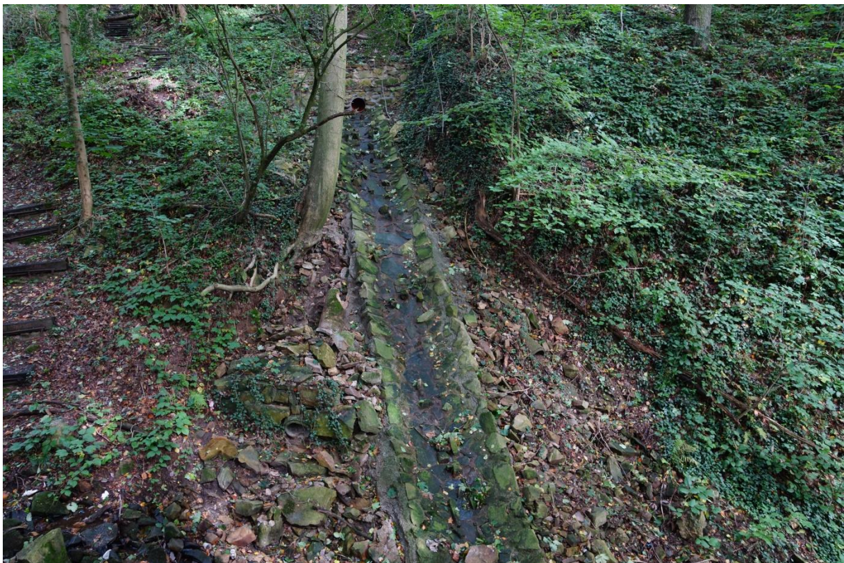
Abbildung 6: Regenwasserableitung direkt unterhalb der Straße
