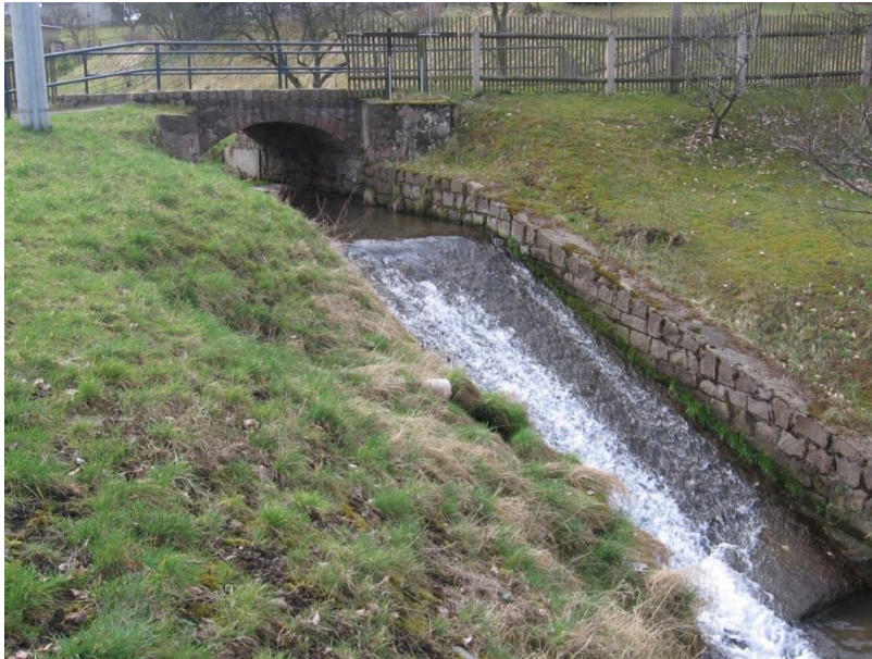
Foto 3: Glatte Rampe Eubaer Bach im Abschnitt 50 (LFULG 2017g)
