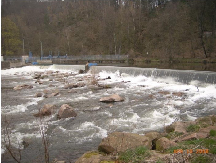
Foto 5: Zschopau mit sehr hohem Absturz (Absturzhöhe: 250 cm) (WKA Webermühle Braunsdorf) im Abschnitt 490 (LFULG 2017g) etwas unterhalb des Mündungsbereichs des Eubaer Bachs
